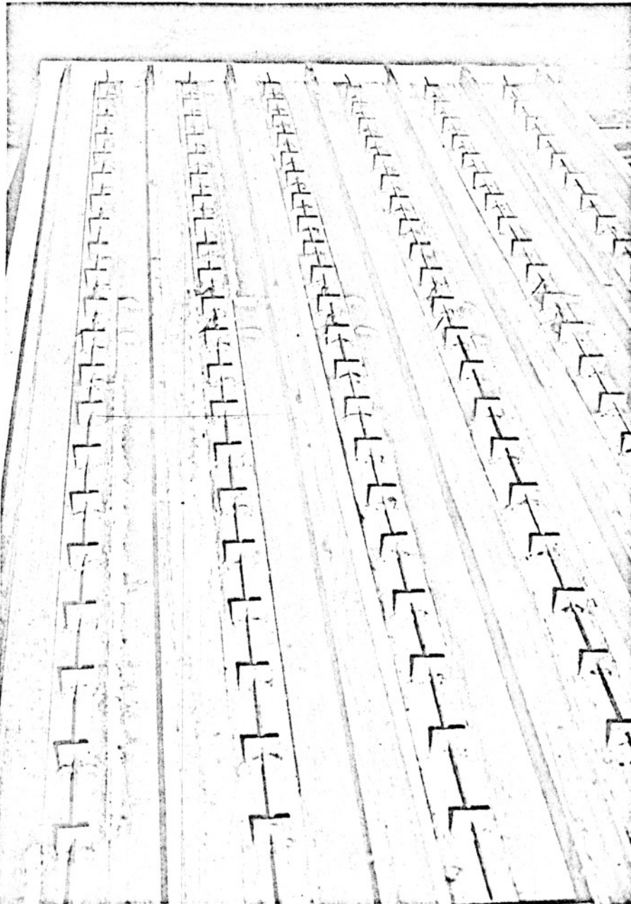
Rys. 6.2. Widok deskowania dźwigarów zespolonych przygotowanego do wypełnienia betonem. Badania I serii.
