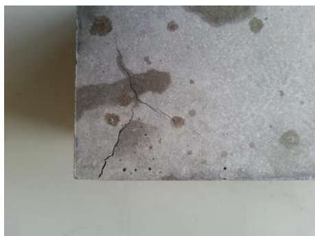
Rys. 2. Pojedyncze spękania powstałe w trakcie badania wg AAR-2.2, kruszywo żwirowe 3 Fig. 2. Single cracks arise during AAR-2.2 test method, gravel aggregates-sample no. 3
