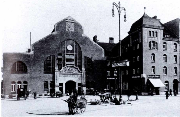
135. Wrocław, ul. Kolejowa 43–45 (Friedrichstraße). Hala Targowa II, 1909, arch. Richard Plüddemann, Heinrich Küster, 1906–1908
