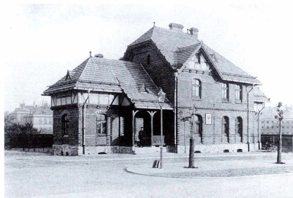
116. Wrocław ul. Władysława Reymonta 13 (Oswitzer Chaussee 1–2). Budynek opłat celnych przy moście Osobowickim. Elewacja frontowa po 1898 r., arch. Richard Plüddemann, Friedrich Friese, 1898–1899
