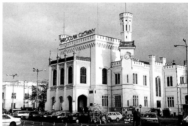
12. Wrocław, Dworzec Główny, arch. Wilhelm Grapow, 1855–1857. Stan obecny
