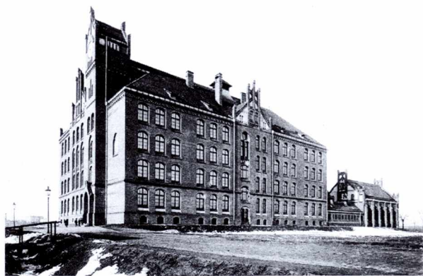
69. Wrocław-Gajowice, ul. Jemiołowa 57. Budynki szkoły ludowej i hali gimnastycznej. Widok od północnego wschodu ok. 1900 r., arch. Richard Plüddemann, Karl Klimm, 1898–1900
