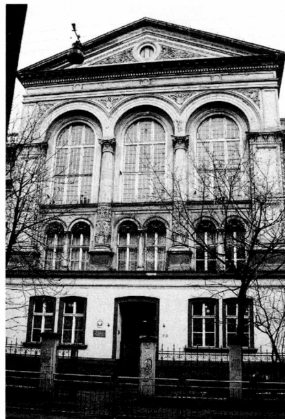
14. Wrocław, ul. Komuny Paryskiej 36–38 (Vorwerkstraße). Szkoła realna (1876–1877), fasada, arch. Robert Mende. Stan obecny
