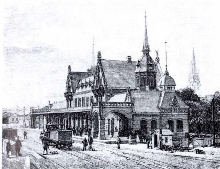
143. Flensburg, dworzec kolejowy, arch. Johannes Otzen, 1883–1885
