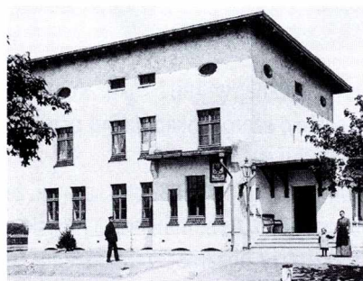
80. Wrocław, ul. Strzegomska 29 (Striegauer Chaussee). Budynek opłat celnych, widok od południa ok. 1903 r., arch. Richard Plüddemann, Friedrich Friese, 1902–1903
