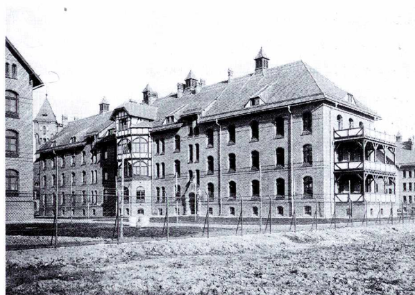
65. Wrocław-Pracze Odrzańskie (Herrnprotsch), ul. Stabłowicka 147-149 (Stabelwitzer Straße). Ośrodek opieki społecznej. Budynek gospodarczo-administracyjny ok. 1902 r., arch. Richard Plüddemann, Karl Klimm, Friedrich Friese, 1900-1902
