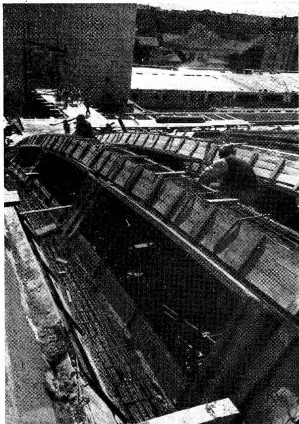
Rys. 16. Dozbrojenie złożonych na rusztowaniu prefabrykatów
