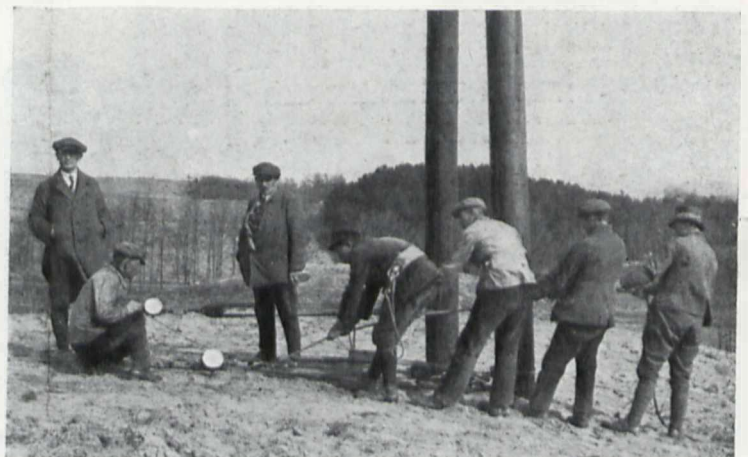
Rys. 25. Naciąganie przewodów za pomocą wielokrążków i dynamometrów, 1925.
