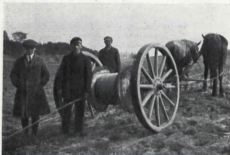
Rys. 24 Rozwożenie linki końmi i wozem 1-osiowym („armatą”). Linja Gródek — Grudziądz, 1925.
