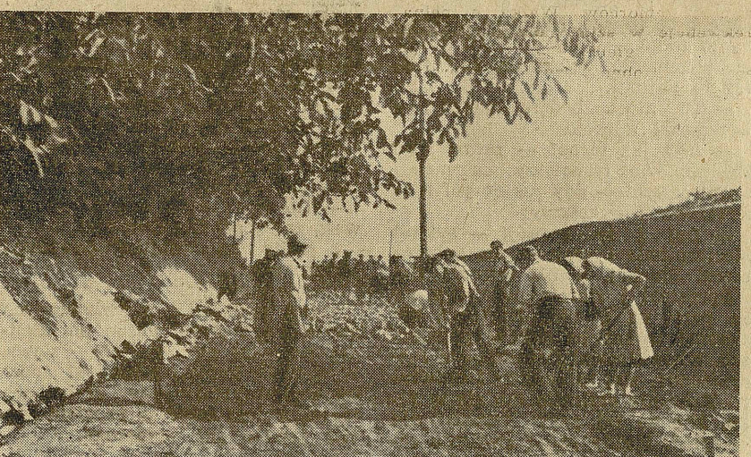
Ludność przy budowie drogi bitej we wsi Wysoka.
