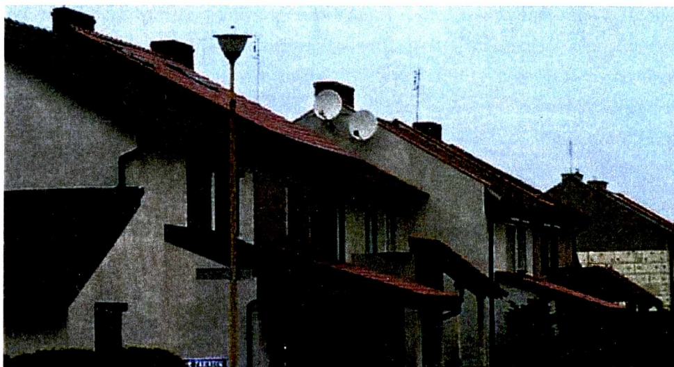
Rys. 157. Osiedle „Demokratka” w Baranowie (arch. P.W. Kowalski), przykład zaprzepaszczenia walorów projektu w trakcie realizacji - „zindywidualizowane” położenie kalenic i daszków nad drzwiami
