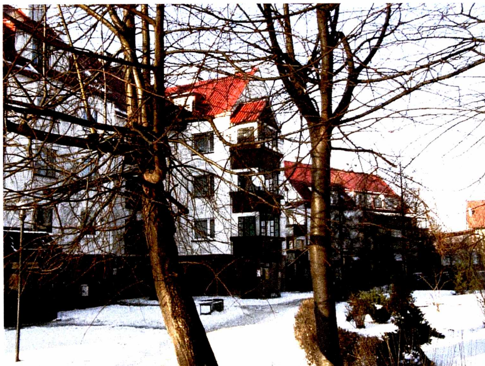
Rys. 37. Osiedle „Sybilla” w Tychach (arch. arch. M. Sokołowska, E. Stachura), budynki 4 i 5 Fig. 37. Housing Estate „Sybilla” in Tychy (designed by M. Sokołowska, E. Stachura), houses No 4 and 5
