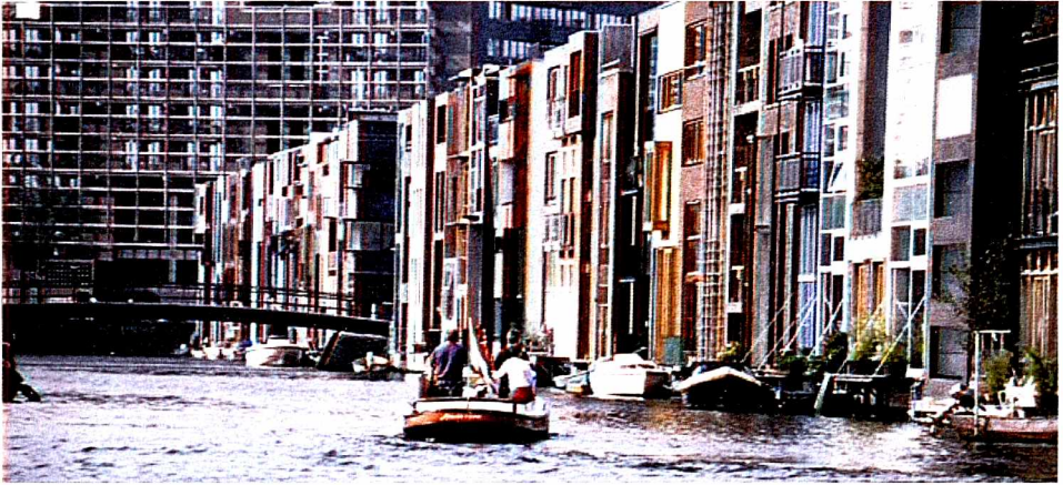
Rys. 28, 29. Osiedle Borneo-Sporenburg w Amsterdamie, Holandia (arch. Grupa West 8 wraz z zaproszonymi architektami), elewacje
