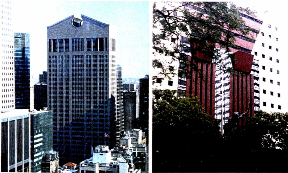
Rys. 7, 8. Wieżowce o historyzującej formie: budynek AT&T w Nowym Jorku (arch. Ph. Johnson), (z lewej), ratusz w Portland (arch. M. Graves), (z prawej) Fig. 7, 8. Historic forms in skyscraper's architecture: AT&T Building in New York (designed by Ph. Johnson), (left), Portland Town Hall (designed by M. Graves), (right)
