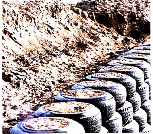
Rys. 89. Ściana z opon w trakcie budowy Fig. 89. Wall made of old tyres under construction
