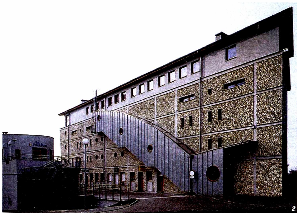
Rys. 76. Budynek mieszkalno-usługowy przy ul. Kruczej, Katowice (arch. arch. R. Jurkowski (główny projektant), A. Nurek), elewacja północno-wschodnia
