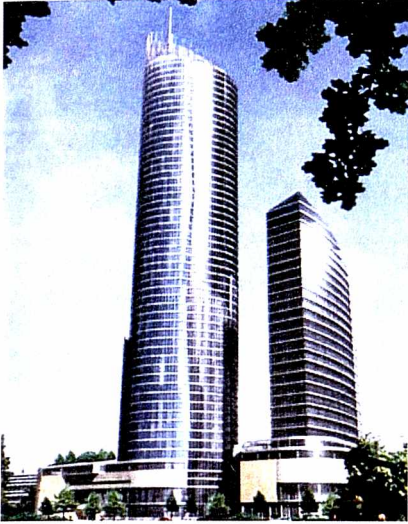
Rys. 60. „Sky Tower” we Wrocławiu (proj. Biuro Projektowe Walas, sp. z o.o.)
