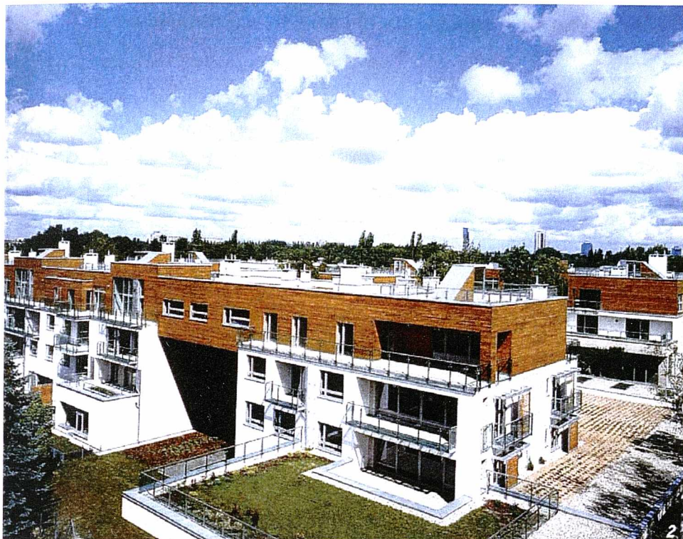
Rys. 78. Osiedle Eko-Park, ul. Rostafińskich, Warszawa (arch. arch. S. Kuryłowicz, P. Grodzicki, P. Gumuła, A. Stefańska), zespół mieszkaniowy A-4, widok zespołu od strony południowo-wschodniej
