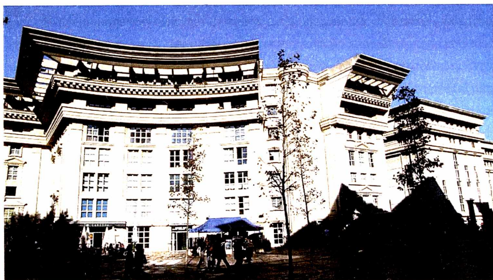
Rys. 15. Kompleks mieszkaniowy Antigone w Montpellier (arch. R. Bofill z zespołem) Fig. 15. Housing Complex Antigone in Montpellier (designed by R. Bofill and team)
