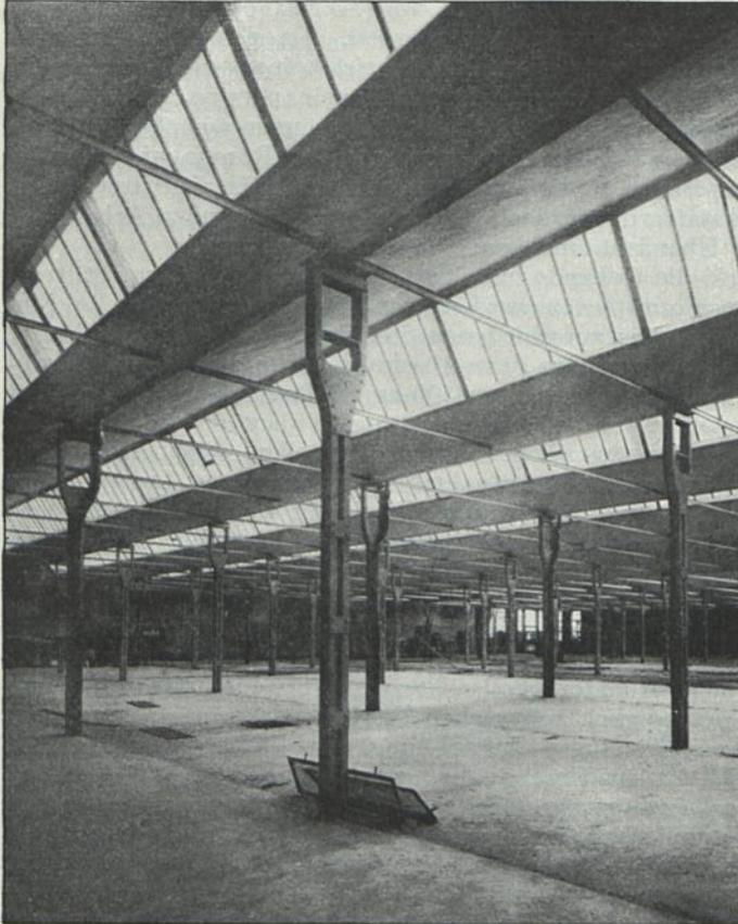
Abb. 168. Flachsaaubau mit Sägedach; Stützen zum Durchziehen von Wellenleitungen eingerichtet. (Aus W. T. 1913, S. 288, W. Franz. Q. 202.)
