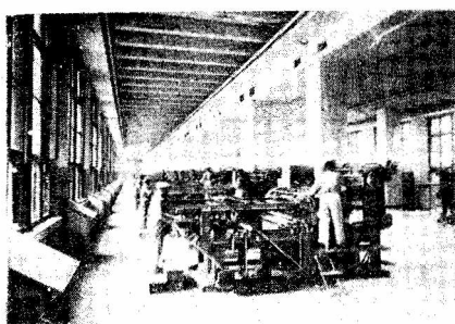
Hala maszyn płaskich
