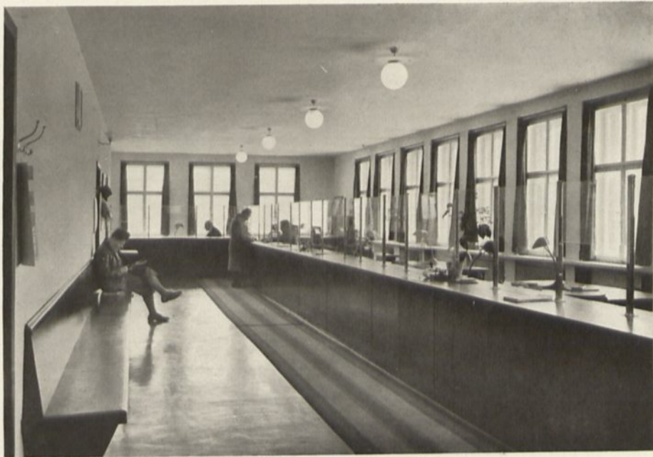
1928 Ortskrankenkasse Sebnitz, Kassenraum
