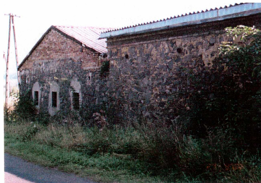
Fot. 45. Budynek gospodarczy w Łękocinie k. Zgorzelca zbudowany częściowo z bloków zgorzelowych
