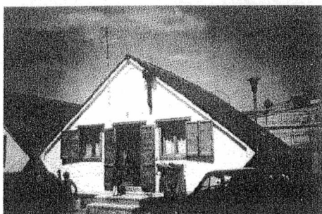
il. 6-2. Betonowy dom prefabrykowany.
