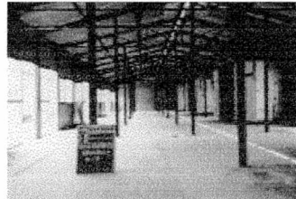
zakończenie demontażu wnętrza
