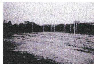
demontaż budynków zakończony
