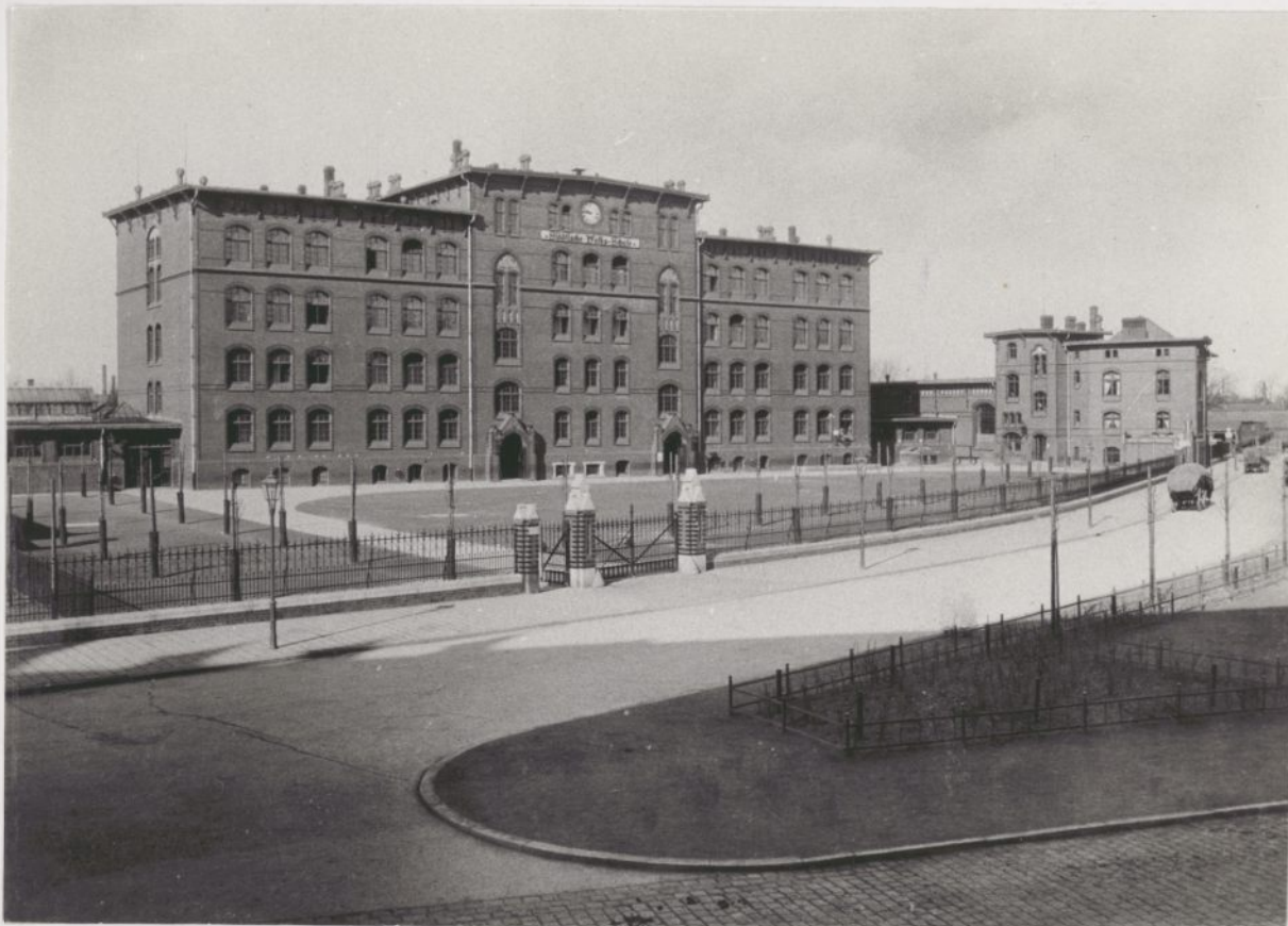
Fot.73 Wrocław, ul.Składowa 2-4 (Magazinstr.). Budynek szkoły ludowej (1895-1897). Elewacja frontowa po 1897r.
