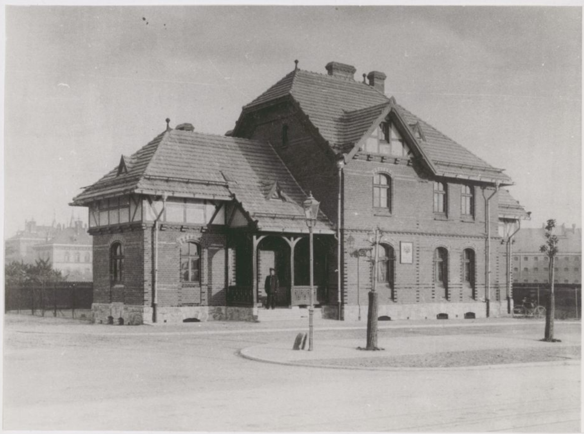
Fot.267 Wrocław ul.Reymonta 13 (Oswitzer Chaussee 1-2). Budynek opłat celnych przy moście Osobowickim (1898-1899). Elewacja frontowa po 1898r.
