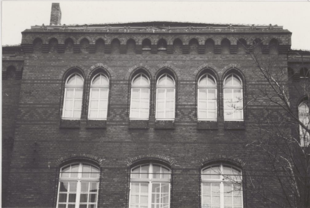
Fot.42 Wrocław, ul.Gliniana 30. Budynek szkoły elementarnej. Fragment elewacji południowej.
