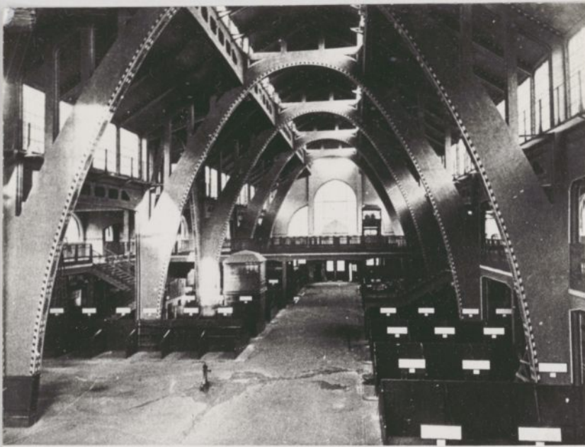
Fot.318 Wrocław, ul. Piaskowa 17 (Ritterplatz 1). Hala Targowa I (1906-1908). Wnętrze w 1909r.
