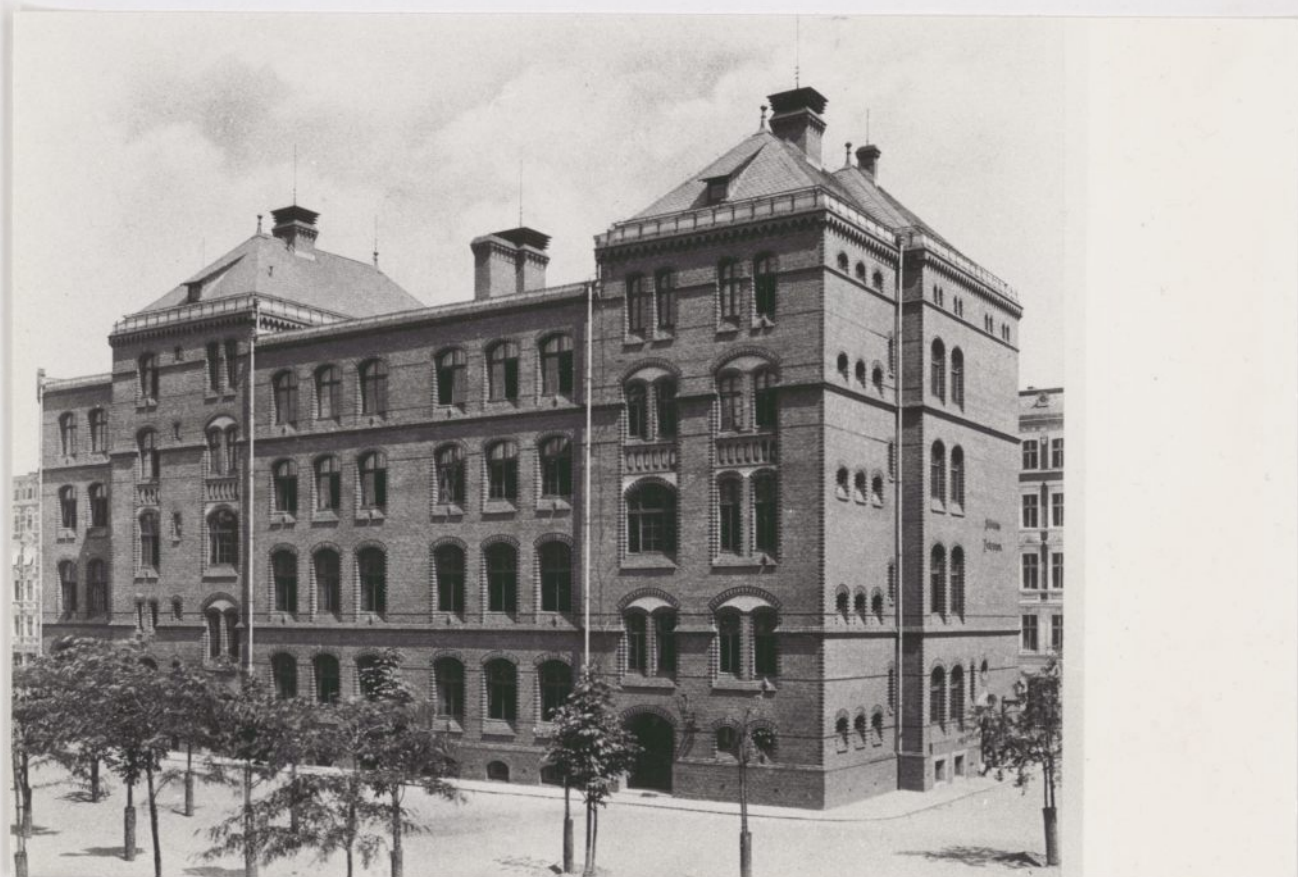
Fot.66 Wrocław, ul.Poznańska 16-20 (Posenerstr.). Budynek II zespołu szkół ludowych (1895-1896). Widok od strony podwórza ok.1896r.
