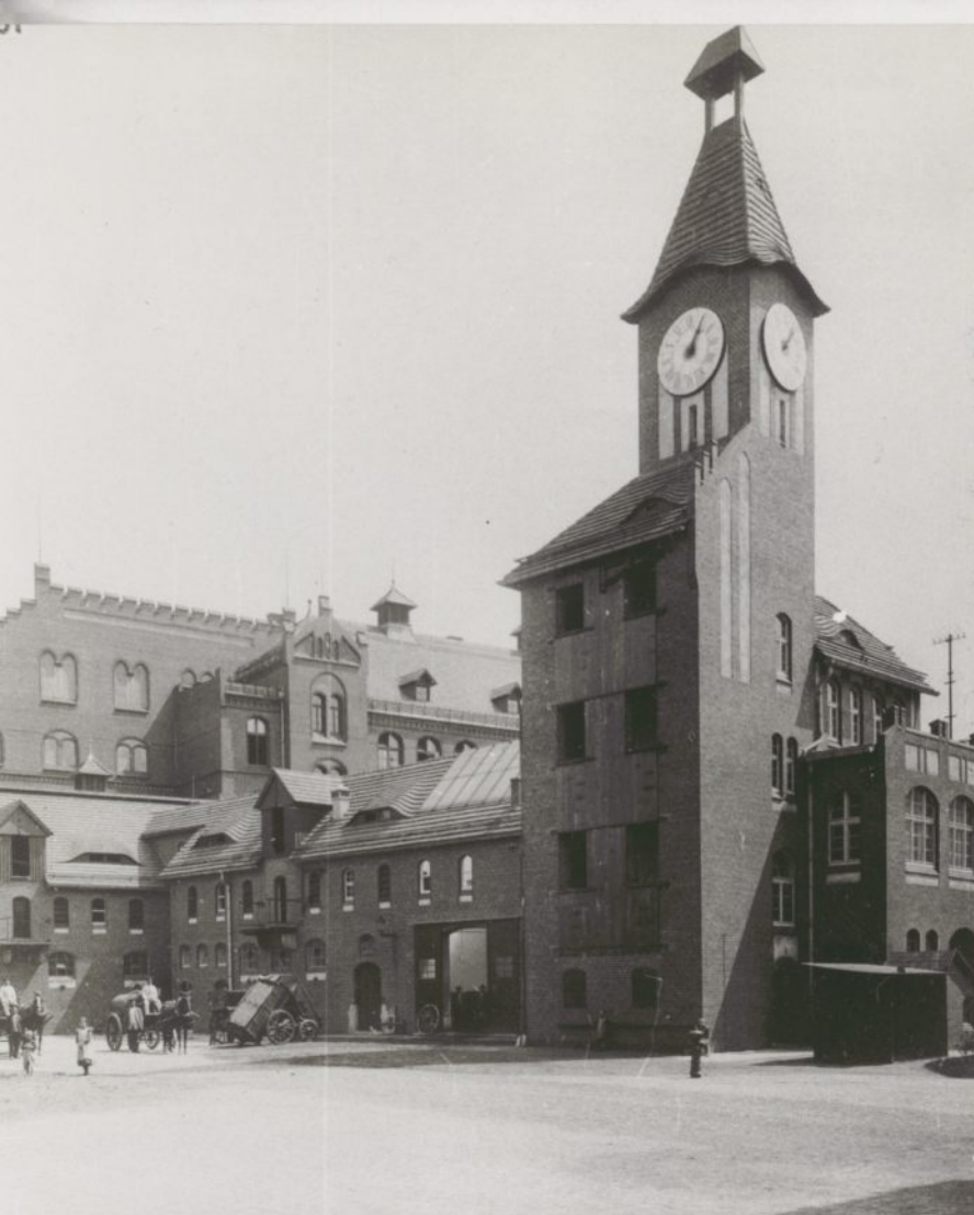
Fot.99 Wrocław, ul. Litomska 63-65 (Leuthenstr.). Komenda Straży Pożarnej nr2. Budynki stajni i warsztatów, w głębi widoczny budynek I zespołu szkół ludowych ok.1905r.
