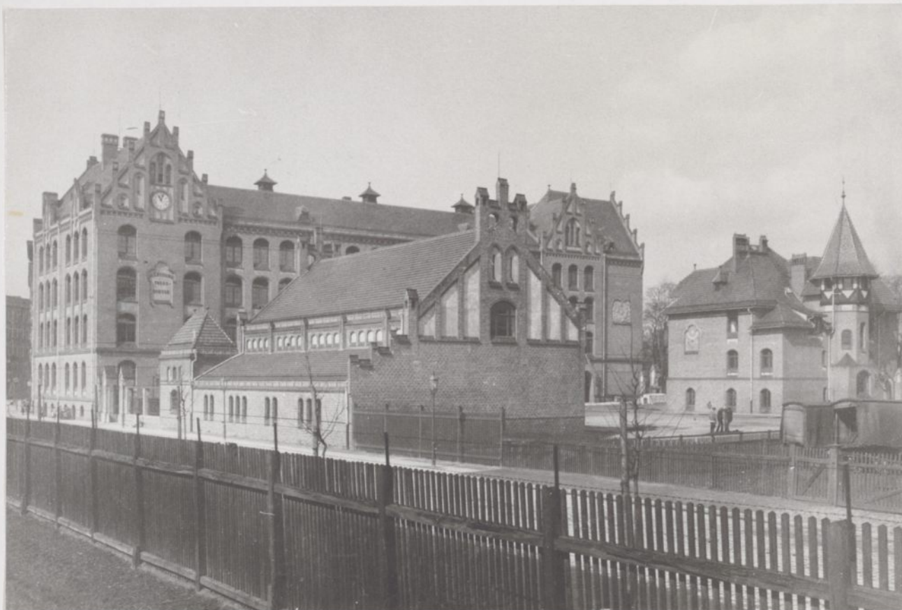
Fot.93 Wrocław, ul.Kleczkowska 2a (Kletschkauerstr.). Budynek I zespołu szkół ludowych (1900-1902). Widok od południowego wschodu na halę gimnastyczną, dom rektora i budynek szkoły ok.1902r.
