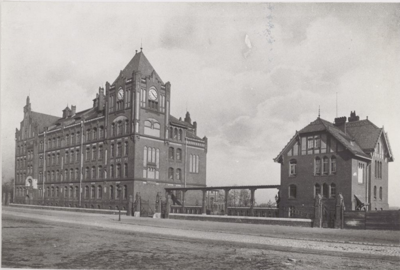
Fot.82 Wrocław, ul. Nowowiejska 78 (Michaelisstr.72-74). Budynek I Zespołu Szkół Ludowych im.J.H.Pestalozziego i dom rektora. Widok od południo- wego zachodu.
