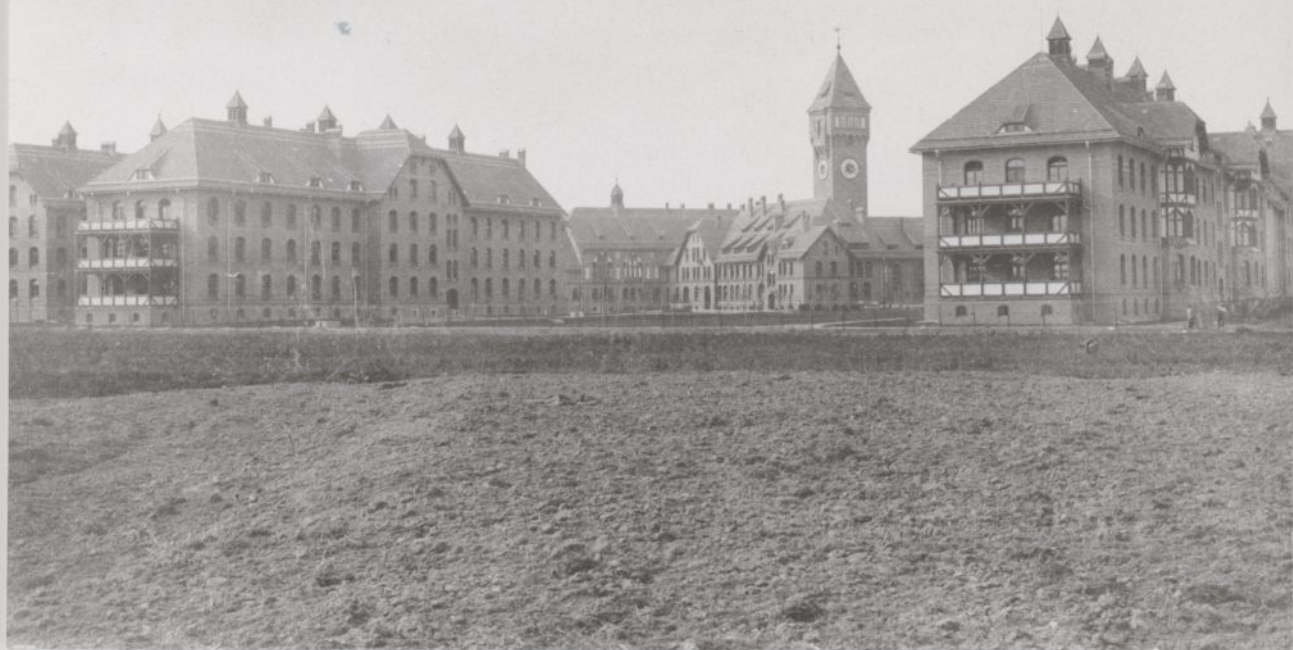
Fot.225 Wrocław - Prace Odrzańskie (Herrnprotsch), ul.Stabłowicka 147-149 (Stabelwitzer Str.). Ośrodek opieki społecznej (1900-1902). Widok od południa ok.1902r.
