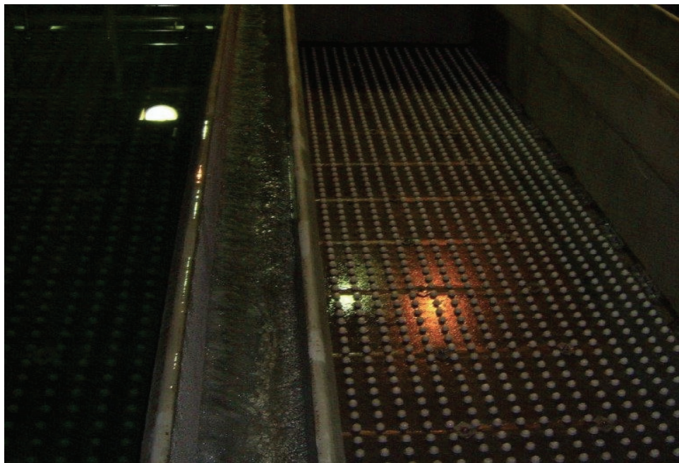
Rys. 48. Drenaż płytowy na dnie filtra (materiały własne)
