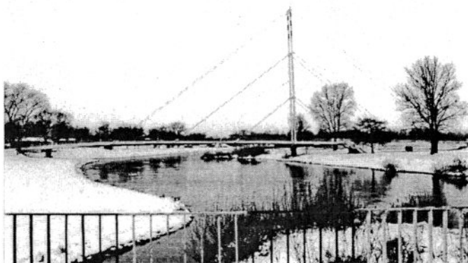
Rys. z1.1. Widok z boku od strony górnej wody na most wantowy przez rzekę Wartę w Sieradzu
