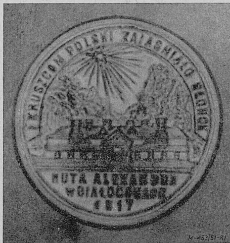
Rys. 1. Plakietka pamiątkowa wydana z okazji ukończenia budowy w r. 1817 huty „Aleksandra” w Białogonie (budowę rozpoczęto na zarządzenia Staszica w czerwcu 1810 r.).
