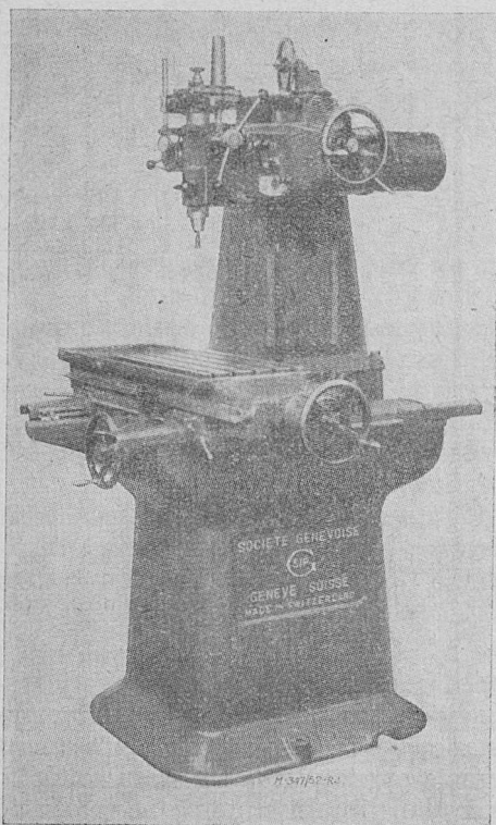
Rys. 5. Wiertarka precyzyjna z urządzeniami korygującymi posuwu wzdłużny i poprzeczny — linały ruchome.
