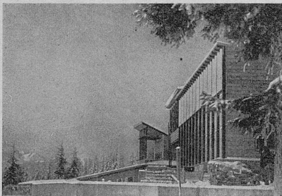
Dolna stacja kolei górskiej.
