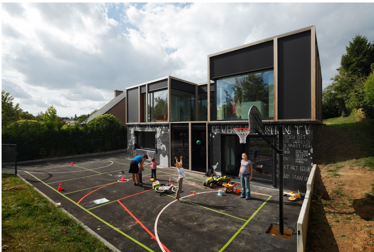
RYSUNEK 3.4.2, rys. 12. Ściany budynku kontynuują wizualnie charakter osłon przeciwsłonecznych poprzez kolor, fakturę i obramowanie.
