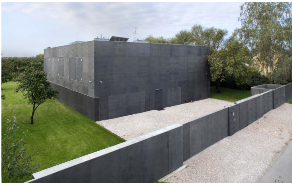
RYSUNEK 3.4.2, rys. 1. Zamknięte okiennice izolują całkowicie wnętrze budynku i redukują bryłę do prostopadłościanu.
