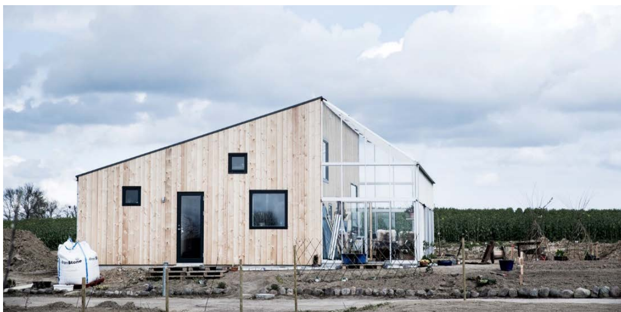
RYSUNEK 3.4.1, rys. 16. Masywna bryła z kompozycją okien z czarnymi ramami dopełniona została szklarnią o subtelnej konstrukcji. Struktura szklarniowa dopełnia budynek do bryły domu o dwuspadowej połaci dachu.
