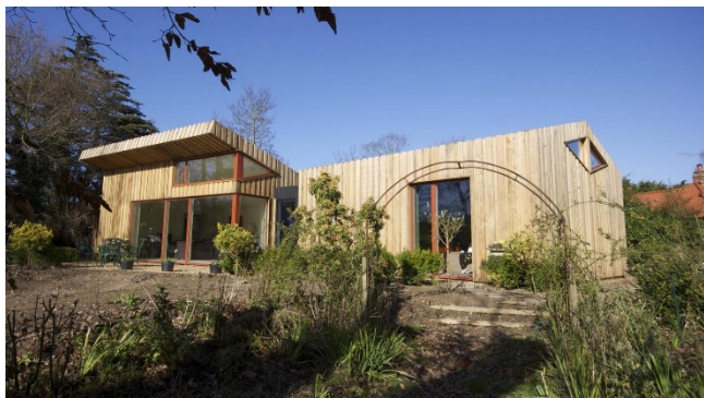
RYSUNEK 3.4.1, rys. 2. Bryła budynku o dachu wielospadowym z połaciami usytuowanymi w różnych kierunkach. W części bryły gdzie dach ma spadek w kierunku północnym zlokalizowane zostały obszerne witryny nastawione na bezpośrednie zyski solarne. W części gdzie dach nachylony jest w kierunku południowym zamontowane zostały systemy aktywne.
