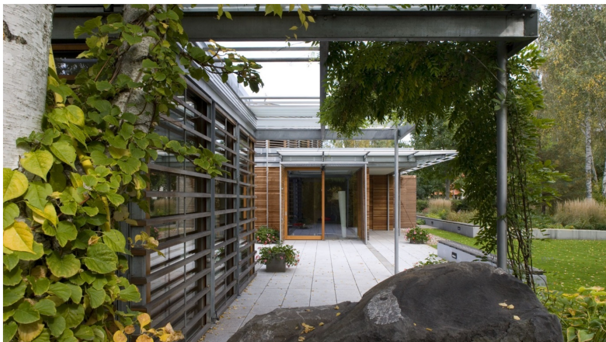
RYSUNEK 2.3.1, rys. 3. Widok na taras przy zachodniej części budynku. Osłony przeciwsłoneczne zintegrowane z budynkiem wzbogacone są o pnącza gubiące liście na zimę.
