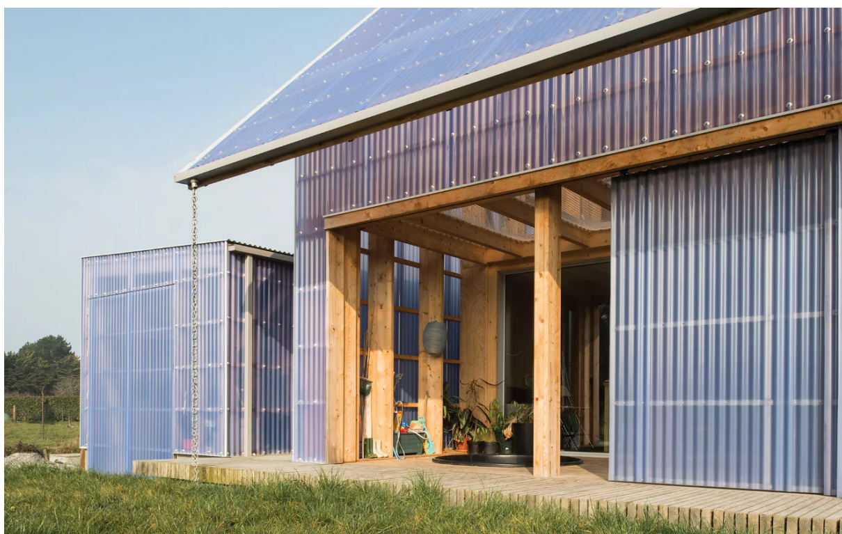
RYSUNEK 3.4.1, rys. 20. Elewacja całego budynku wraz z dachem pokryta jest powłoką z tworzywa sztucznego. Na zdjęciu widać południowo-zachodni narożnik budynku w którym znajduje się cieplarnia-taras i dalej kuchnia w wewnętrznej bryle budynku.
