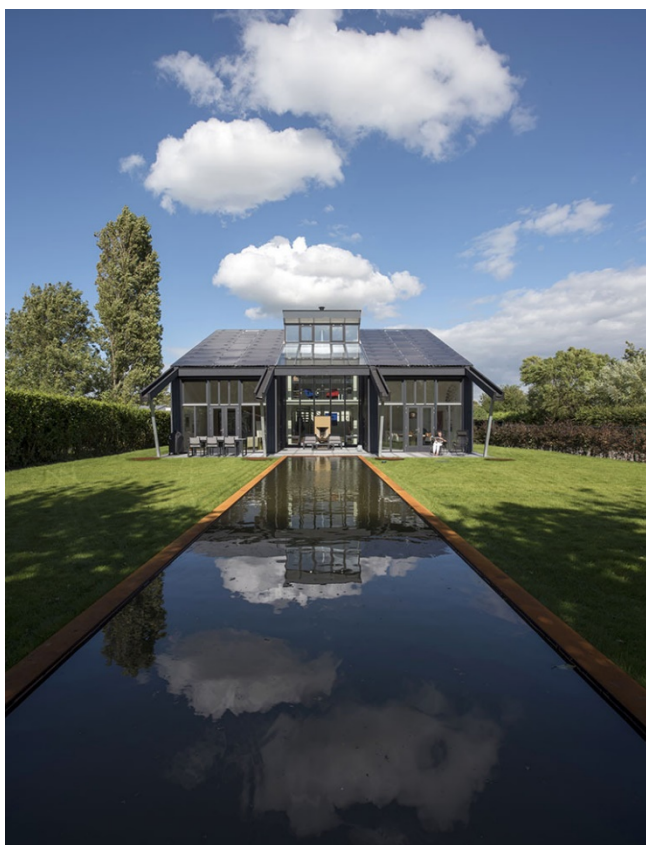
RYSUNEK 3.4.1, rys. 3. Bryła budynku podzielona jest na trzy segmenty. Część środkowa posiada połacie zwróconą w kierunku północnym dzięki czemu zwiększona została powierzchnia szklanej fasady zwróconej na południe. Skrajne połacie zwrócone w kierunku południowym posiadają systemy aktywne.
