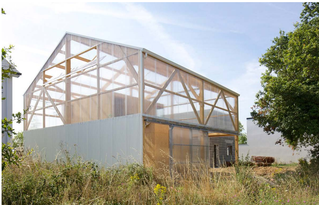
RYSUNEK 3.4.1, rys. 19. Budynek wewnątrz szklarni. Powłoka zewnętrzna z tworzywa sztucznego, tłoczonego w falę.
