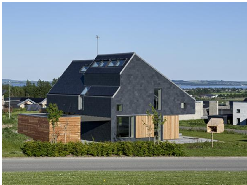
RYSUNEK 3.6, rys. 5. Widok od strony północno zachodniej. W szczycie dachu widać baterię okien wspomagających wentylację naturalną
