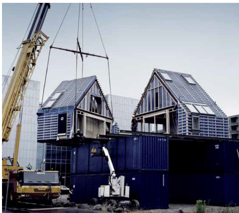
RYSUNEK 2.3.2, rys. 2. Budynek podczas montażu.
