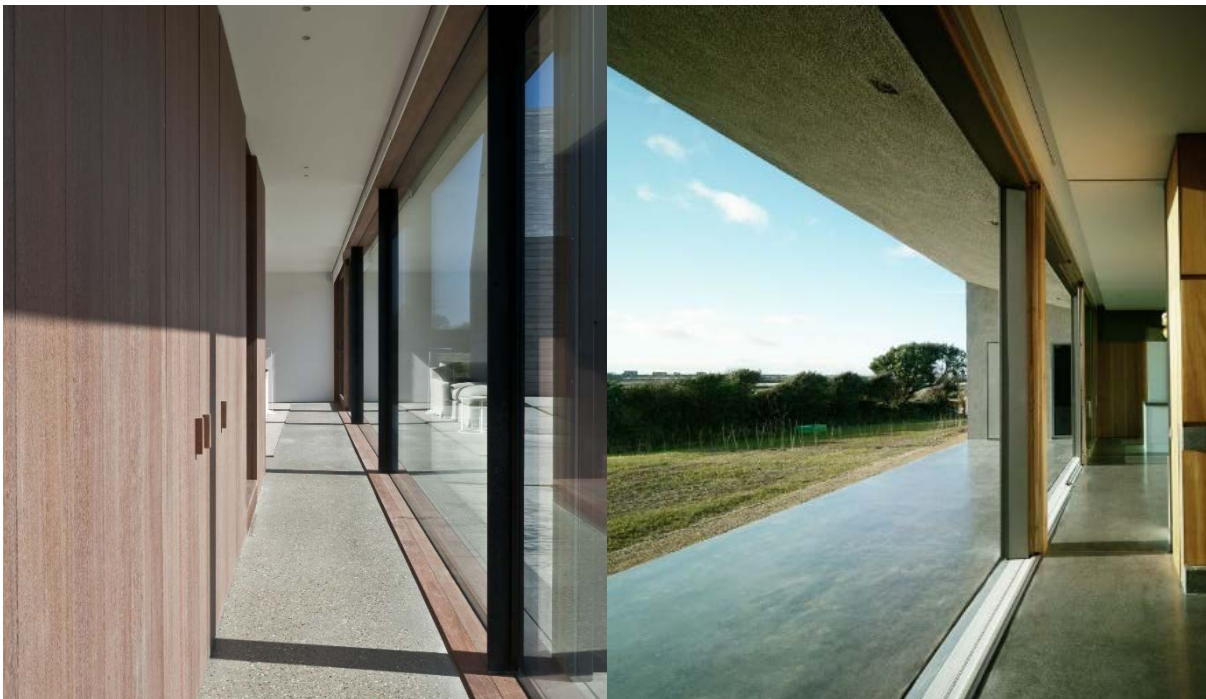
RYSUNEK 3.3.1, rys. 7. Posadzka we wnętrzu wykonana z jasnego lastryko jest główną widoczną masą termiczną.
