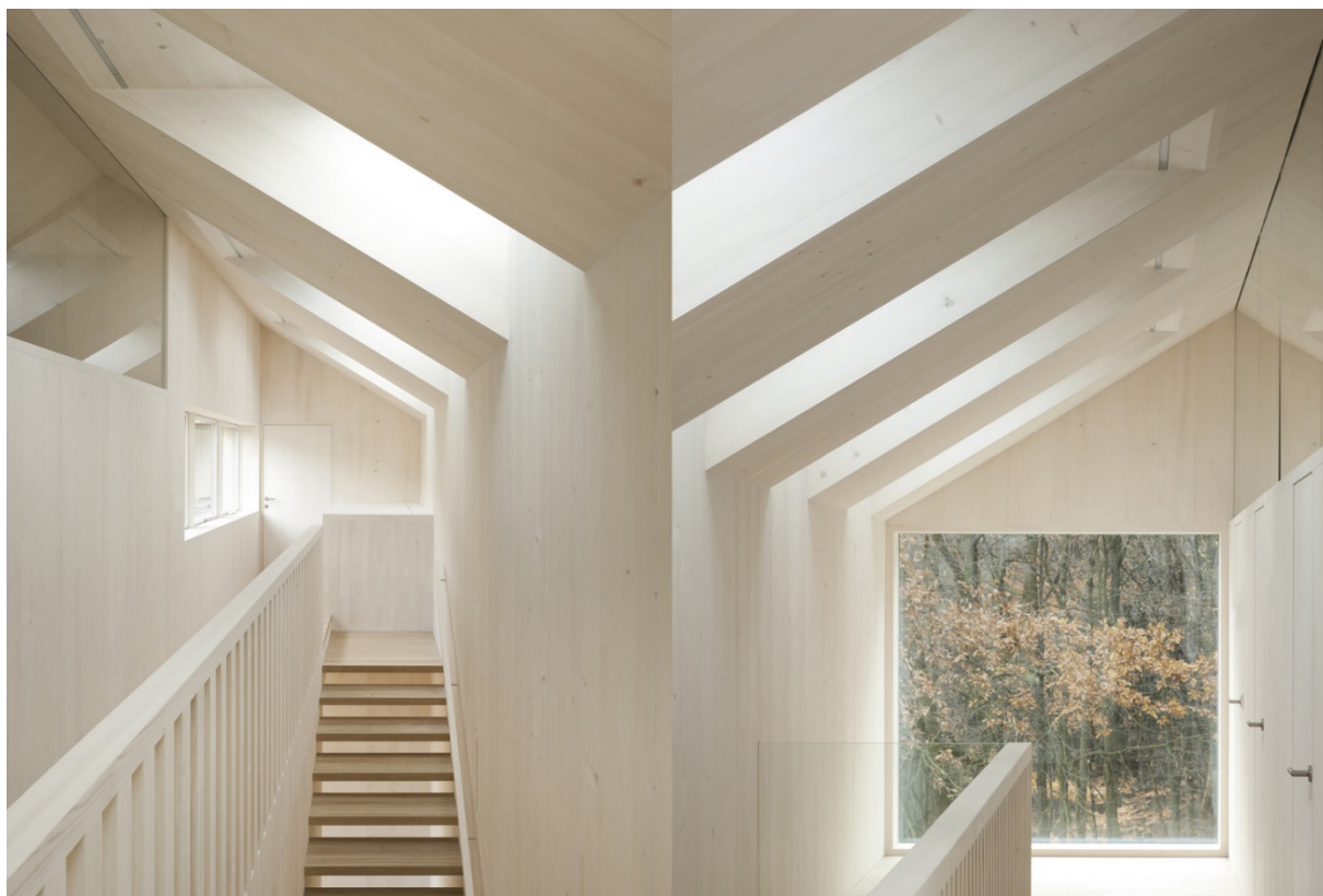
RYSUNEK 3.5, rys. 1. Naświetla w ścianie między korytarzem a pokojami. Ich lokalizacja w bliskiej odległości od okien połaciowych poprawia warunki oświetleniowe.
