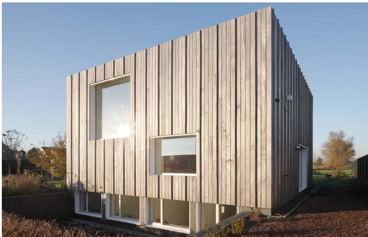
RYСУNEK 3.3.2, rys. 3. Widok od strony południowej. Przed oknami na najniższej kondygnacji znajduje się obniżenie terenu umożliwiające lepsze doświetlenie wnętrza pomieszczeń.
