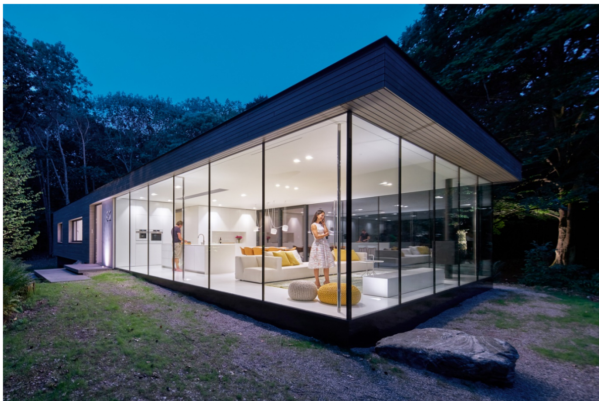
RYSUNEK 3.4.2, rys. 14. Obszerne przeszklenia w części dziennej bez osłon przeciwsłonecznych zintegrowanych z budynkiem.
