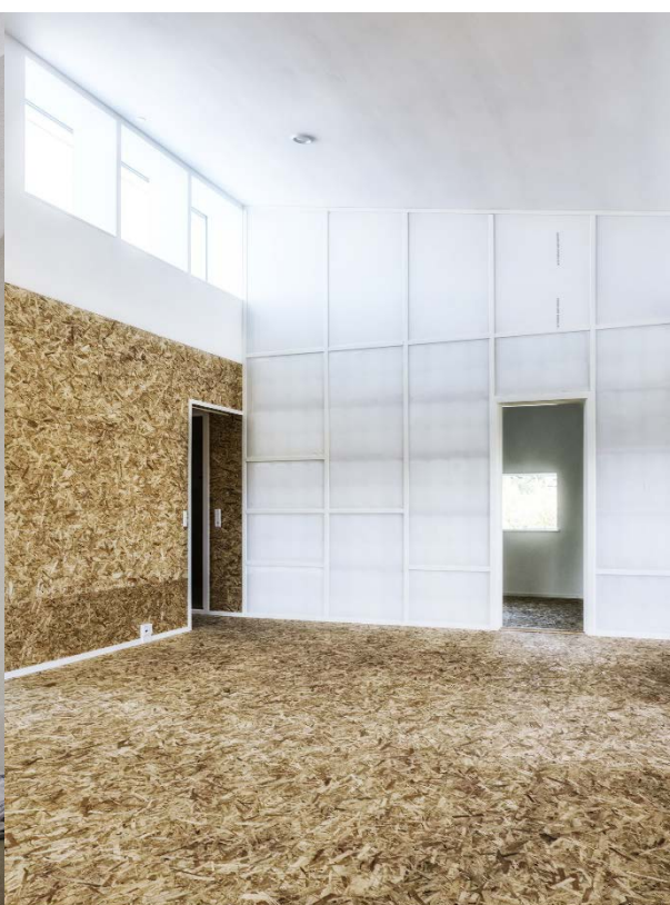
RYSUNEK 3.3.1, rys. 12. Ściana wypełniona pojemnikami z wodą po ukończeniu. Przez delikatnie transparentną powłokę ściany prześwitują zbiorniki w jej wnętrzu.
