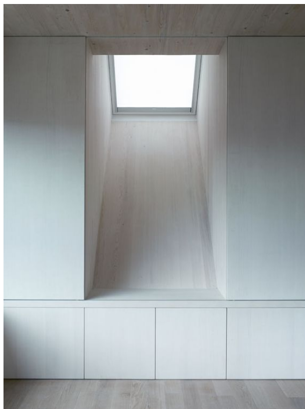
RYSUNEK 3.5, rys. 2. Okno połaciowe w strefie dziennej zlokalizowane w charakterystycznej głębokiej wnęcie,
