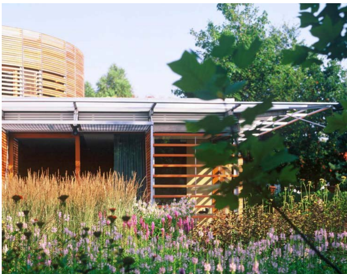
RYSUNEK 2.3.1, rys. 4. Widok na południowo-wschodni narożnik budynku.
