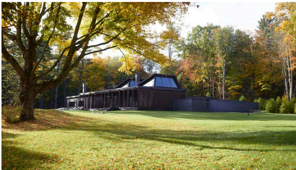
RYSUNEK 3.5, rys. 3. Świetliki o charakterystycznej dynamicznej bryle zlokalizowane na dachu budynku.
