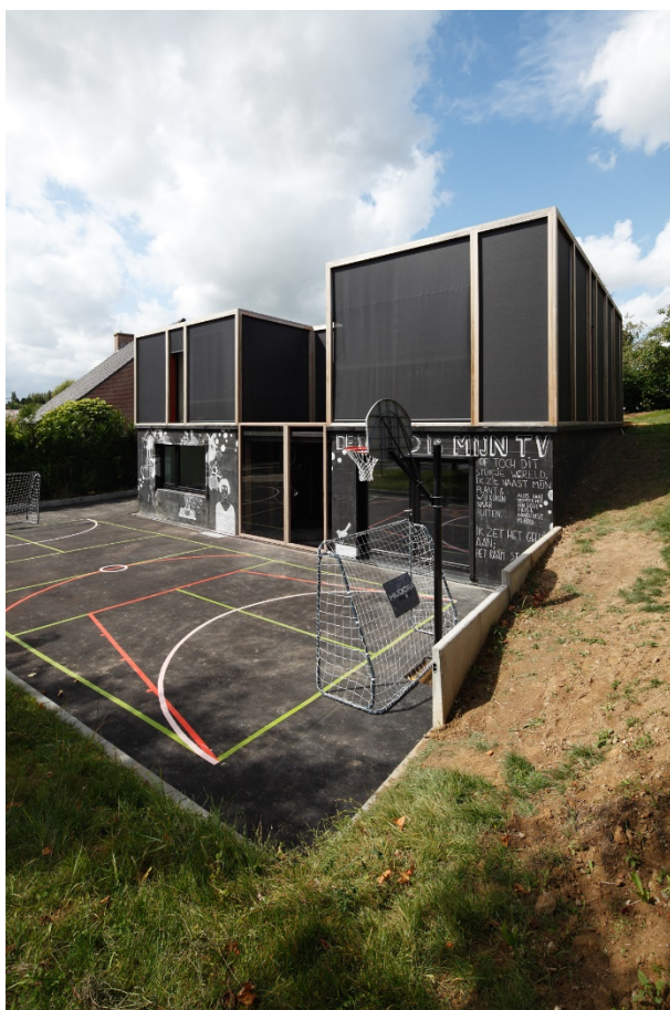
RYSUNEK 3.4.2, rys. 13. Rolety po zamknięciu zmieniają dynamikę elewacji. Ujednolicenie materiału sprawia, że przy opuszczonych osłonach trudno określić lokalizację okien.
