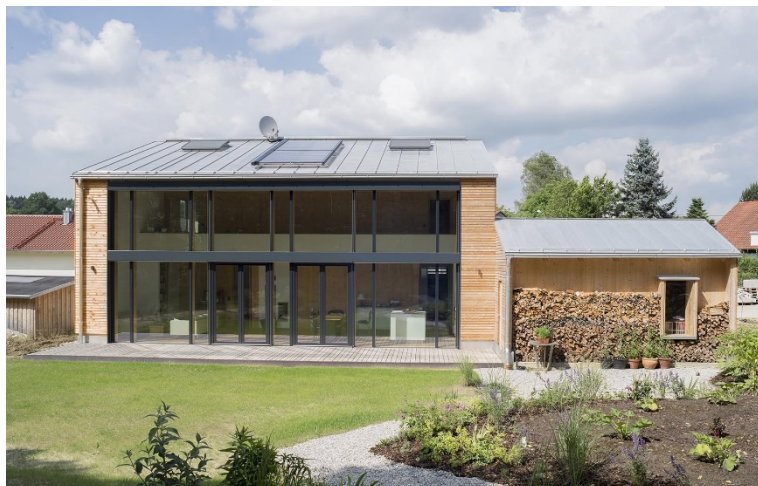
RYSUNEK 3.4.1, rys. 5. Widok elewacji południowej. Jako osłony przeciwsłoneczne zaprojektowane zostały żaluzje regulowane.
