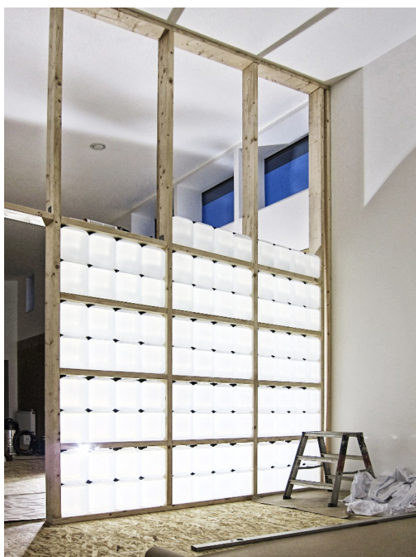
RYSUNEK 3.3.1, rys. 11. Ściana wypełniona pojemnikami z wodą podczas budowy.
