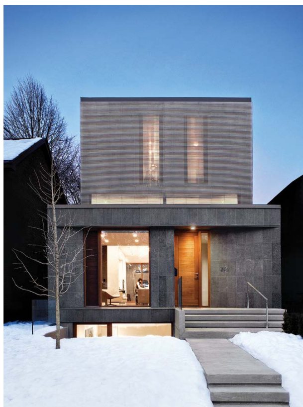
RYСУNEK 3.3.2, rys. 4. Widok od strony południowej. Na najniższej kondygnacji od strony południowej znajduje się pomieszczenie zabaw dla dzieci. Okna we wnętrzu znajdują się stosunkowo wysoka. Od zewnątrz obniżony został teren co zwiększa ilość światła docierającego do wnętrza.
