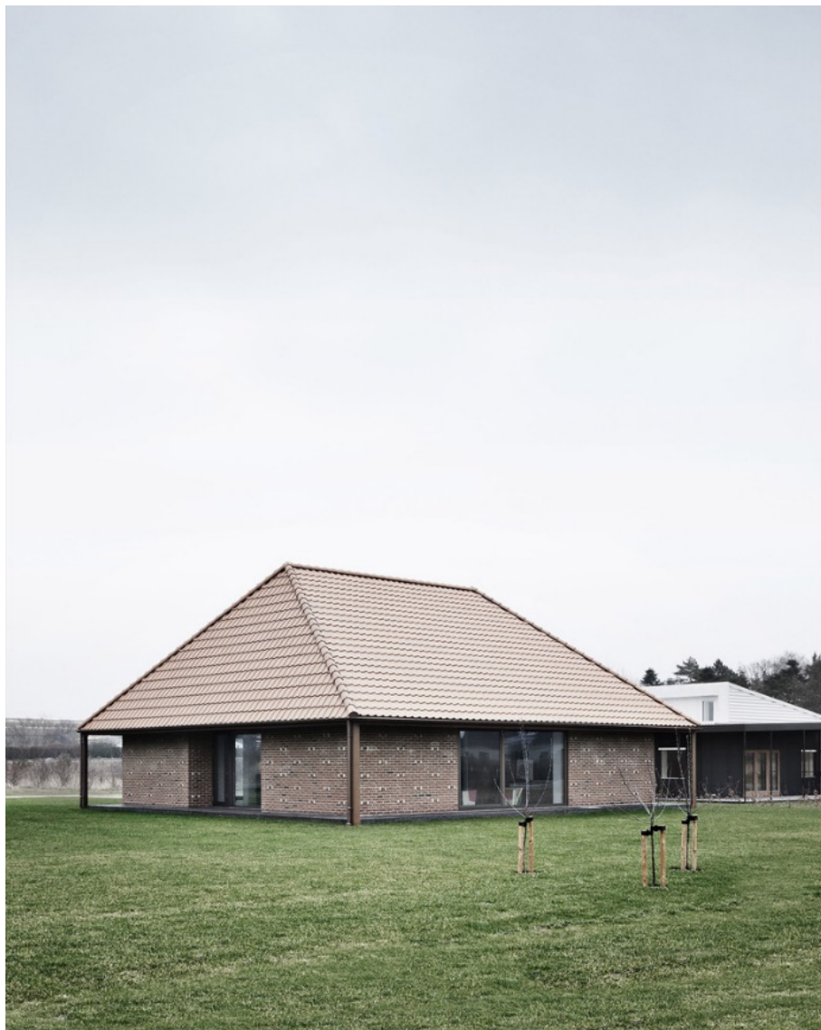
RYSUNEK 3.4.2, rys. 10. Widok od południowego zachodu. Wielospadowy dach z obszernymi okapami stanowiącymi osłony przeciwsłoneczne. Wycofane do wnętrza bryły witryny w ścianach północnej i południowej zwiększają zacienienie.
