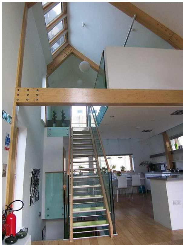
RYSUNEK 3.6, rys. 9. We wnętrzu widoczne są okna połaciowe za pomocą których regulowany jest przepływ powietrza. Otwarta przestrzeń wnętrza ułatwia wentylację.
