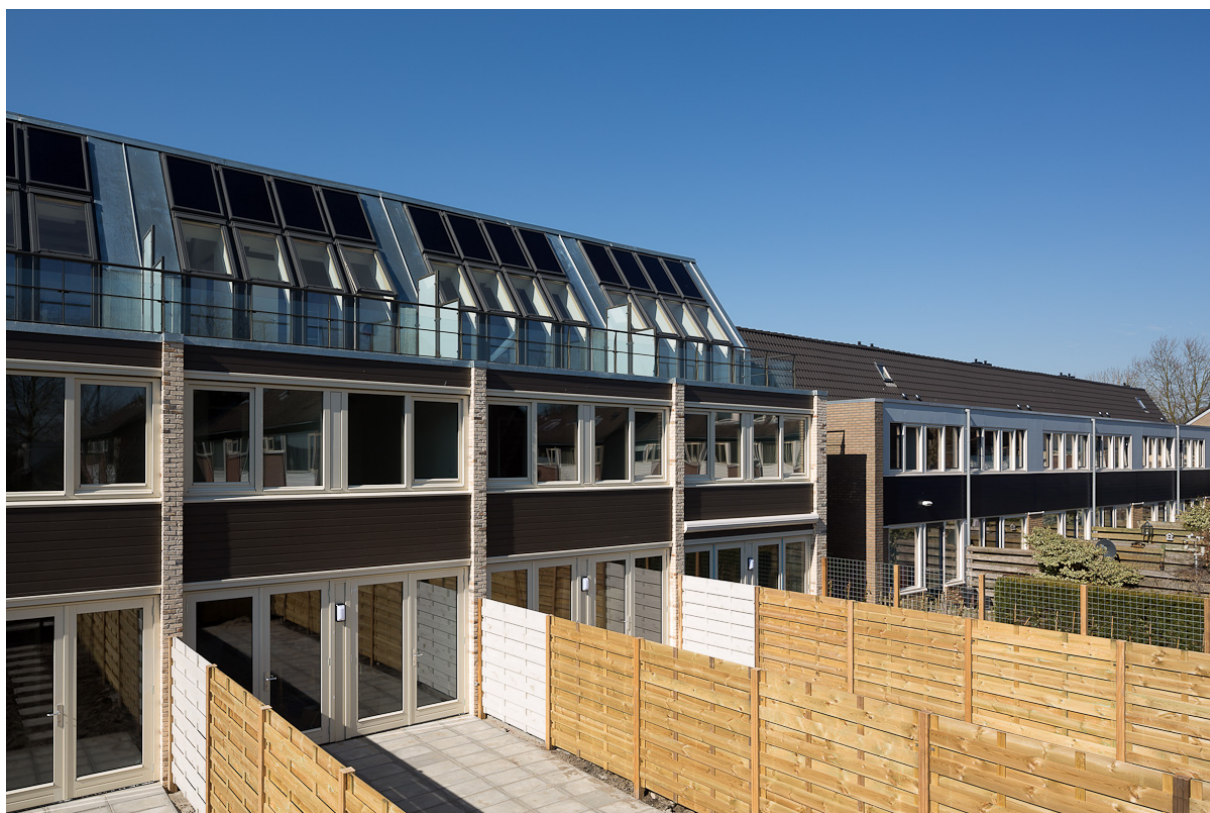
RYSUNEK 2.3.11, rys. 2. Widok na budynki po renowacji od strony wschodniej. W tle budynki, na których nie przeprowadzono modernizacji.
