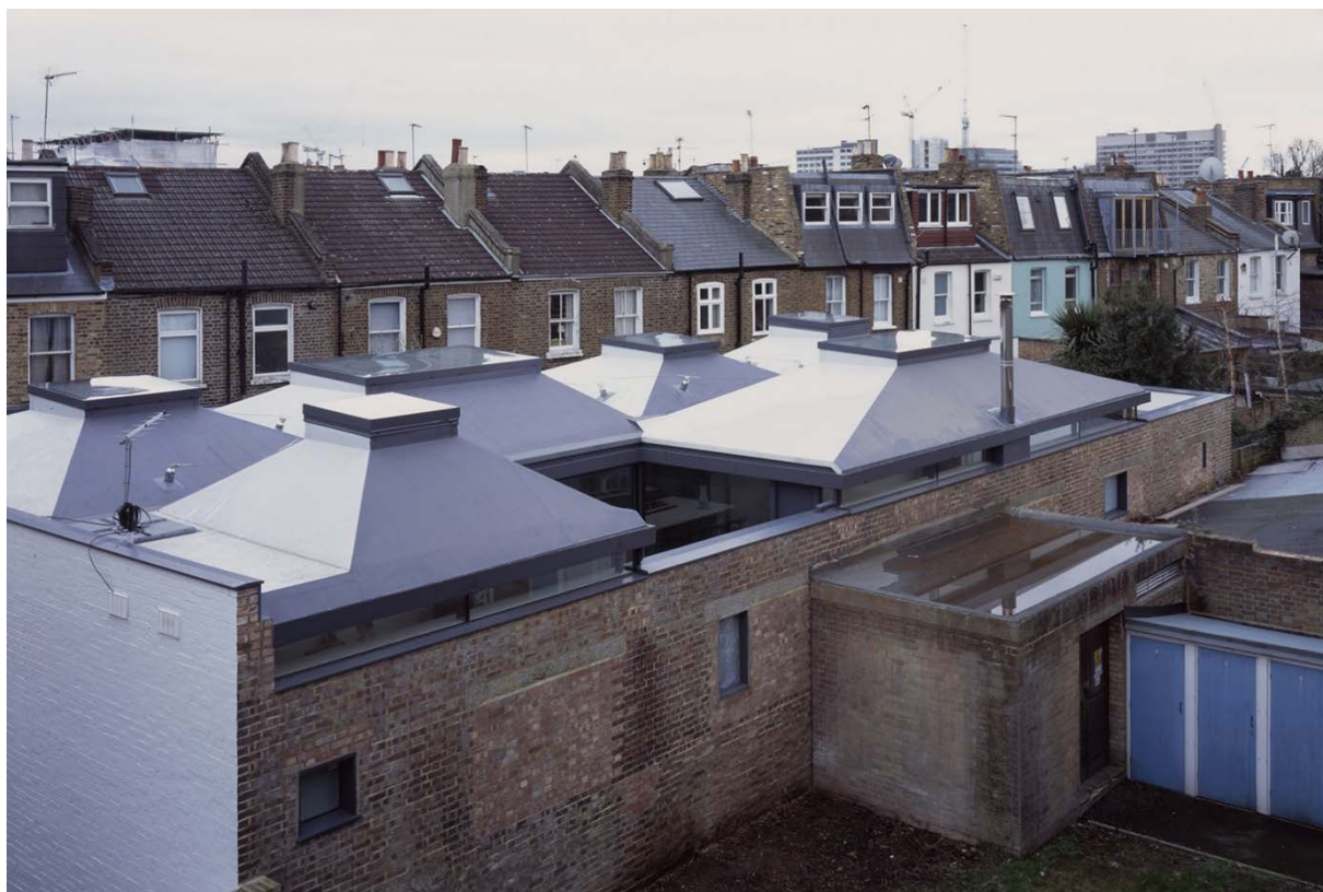
RYSUNEK 3.4.1, rys. 12. Budynek prawie w całości wypełnia działkę w zwartej miejskiej zabudowie. Lokalizacja taka ogranicza możliwość stosowania okien w ścianach, w związku z czym projektanci zaproponowali doświetlenie świetlikami tworzącymi charakter budynku.
