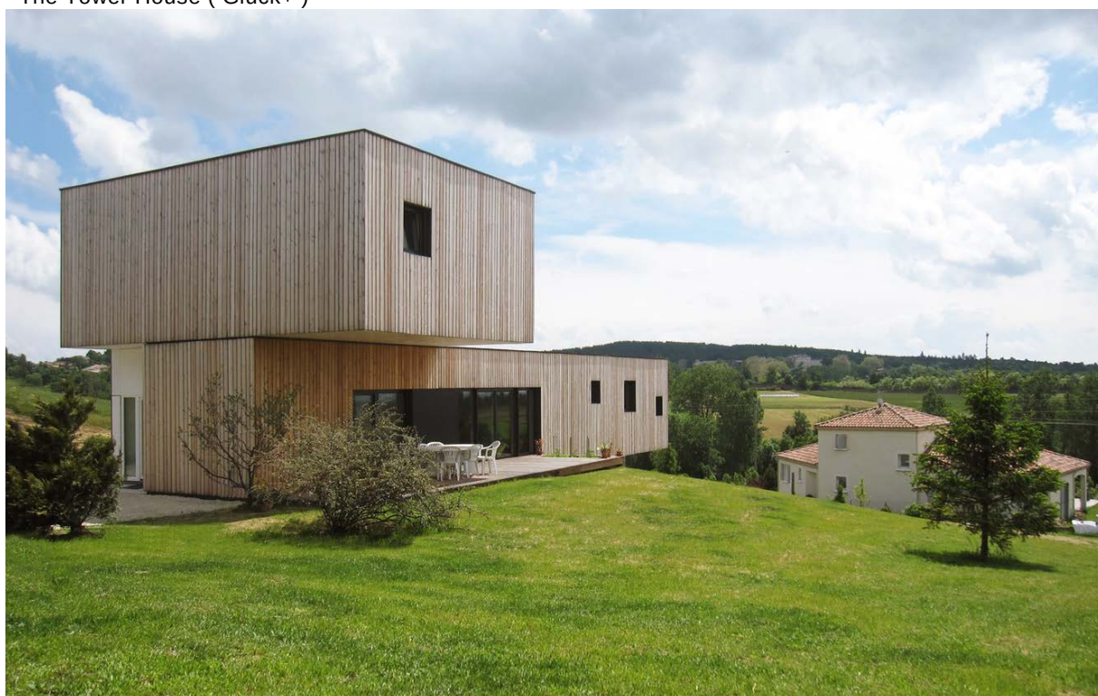
RYSUNEK 3.3.2, rys. 10. W bryle stanowiącej najwyższą kondygnację znajdują się sypialnie. Nadwieszenie stanowi zadaszenie nad tarasem oraz zapewnia stałą osłonę przeciwsłoneczną okien w strefie dziennej.
