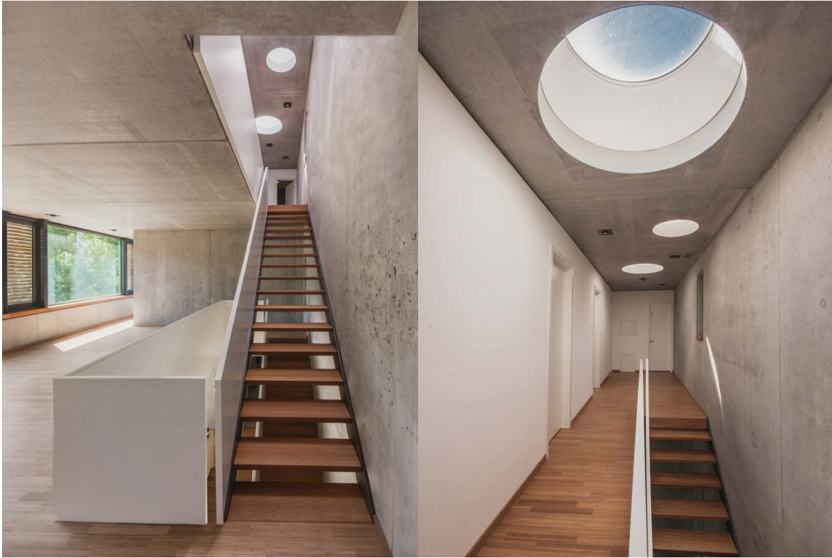
RYSUNEK 3.3.1, rys. 5-6. Konstrukcja z betonu pozostaje odkryta eksponując, w budynku podkreślone jest w ten sposób, które elementy pełnią funkcję konstrukcyjną. Ściany działowe wykonane w innej technologii zostały otynkowane co podkreśla ich materiałową odmienność i pełnioną funkcję.
