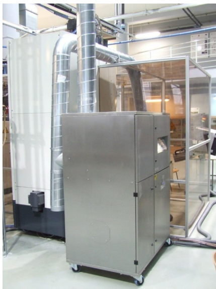
Rys. 2.17. System filtracji PUREX Laserex 4000
