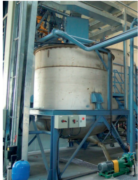
Rys. 2.20. Zasobnik na gotowy zaczyn o pojemności 7,0 m 3 ; fot. T. Gorzelańczyk
