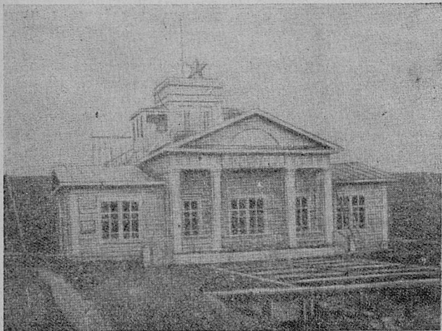
Rys. 5. Elektrownia wodna kolchozu „Zaria“ w okręgu aczyckim
