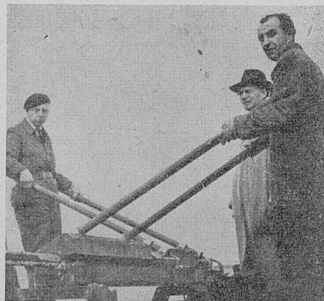
Rys. 15. Hamowanie kabla opuszczanego do wody
