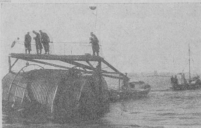
Rys. 10. Bęben pływający
