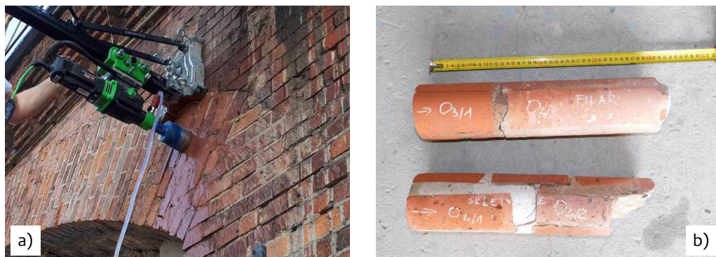
Rys. 7.17. Próbkę murowe badanej estakady kolejowej E4: a) przebieg wycinania, b) uzyskane próbki
