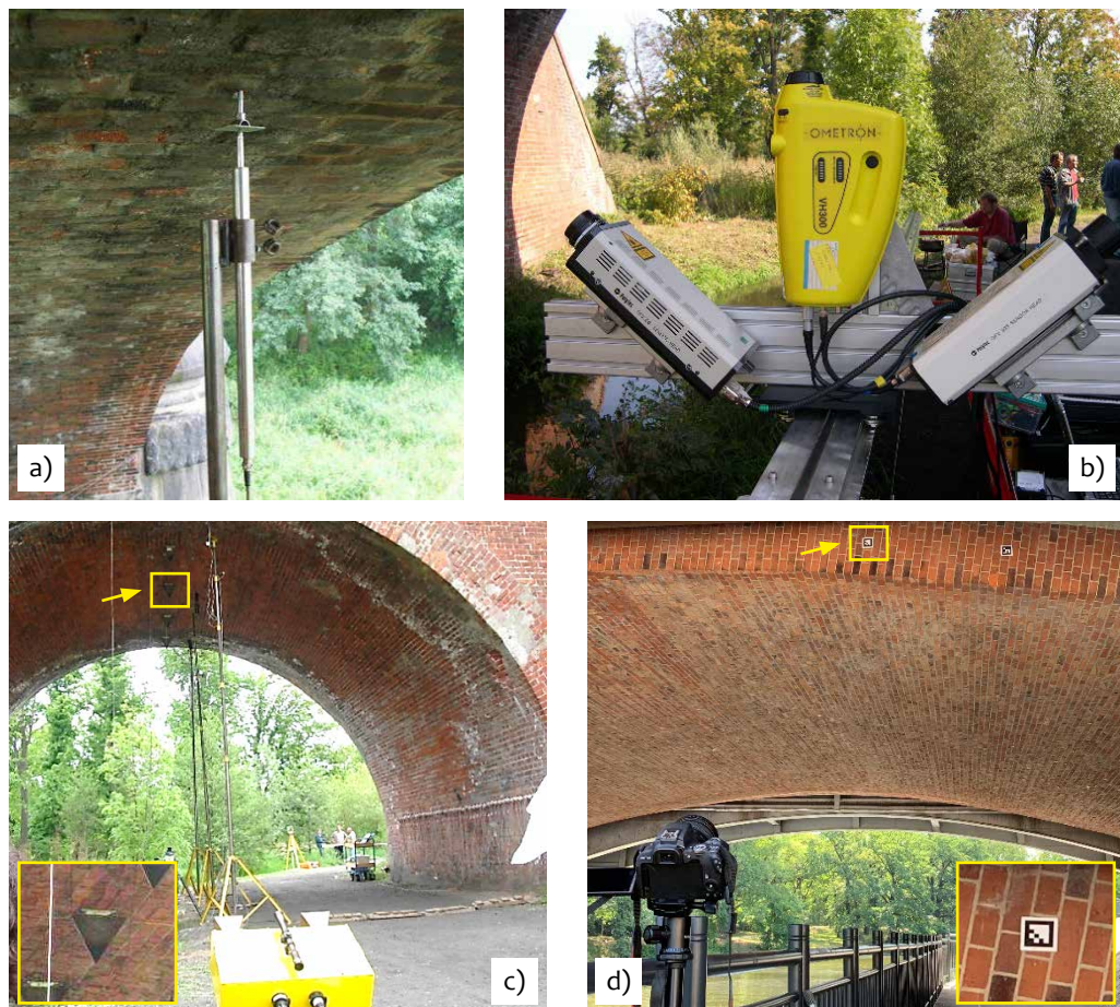
Rys. 5.3. Pomiar deformacji sklepienia za pomocą: a) czujnika LVDT, b) czujników laserowych, c) radaru inferencyjnego, d) cyfrowej korelacji obrazu
