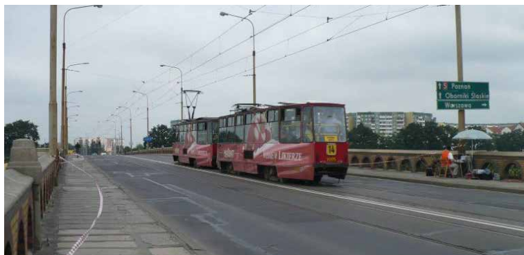
Rys. 5.17. Pojazdy przejeżdżające przez obiekt w trakcie pomiaru nr 2
