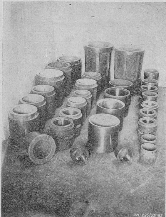
Rys. 2. Panewki do różnych typów obrabiarek, natryskane stopem Cu—Pb.
