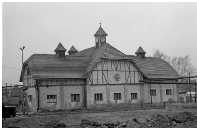
Il. 1.13. Budynek ratownictwa górniczego przy kopalni Thorez (szyb Jan); zbiory Politechniki Wrocławskiej, fot. M. Czulczyński
