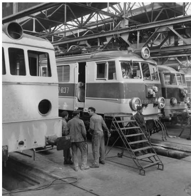
Il. 1.18. Montaż lokomotyw w Fabryce Wagonów Pafawag; Centrum Historii Zajezdnia, Archiwum Ośrodka Pamięć i Przyszłość, fot. S. Kokurewicz
