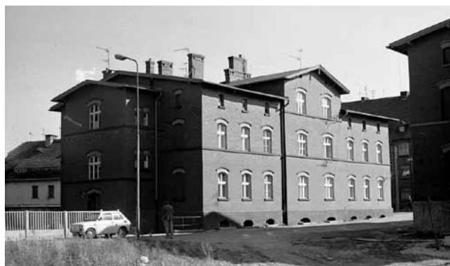
Il. 1.14. Budynki osiedla górniczego kopalni Wałbrzych; zbiory Politechniki Wrocławskiej (IHASzIP)
