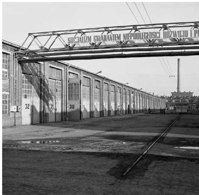
Il. 1.17. Hale Fabryki Wagonów Pafawag wybudowane w 1895 r.; zbiory Politechniki Wrocławskiej, fot. Z. Ścibor
