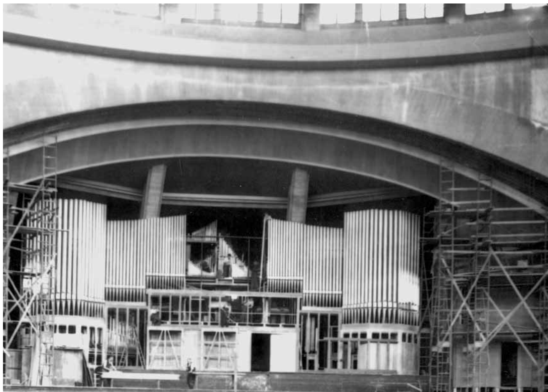
Il. 1.3. Budowa Hali Stulecia w 1913 r.; Marburg Kunstgeschichtlichen Institut der Philipps-Universität Marburg
