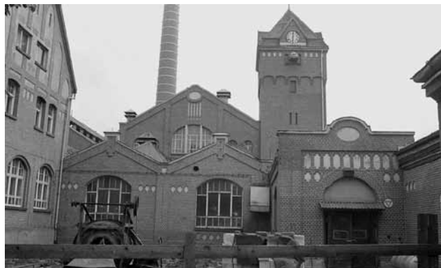
Il. 1.11. Zakłady im. H. Sawickiej (wieża wodna, budynki administracyjne i produkcyjne) w Kudowie-Zdroju (1985); zbiory Politechniki Wrocławskiej
