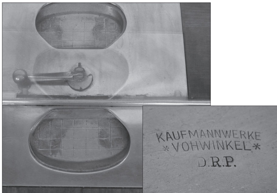
Element obrotowy kasy na legnickim dworcu kolejowym. Fot. K. Kuszyk.
