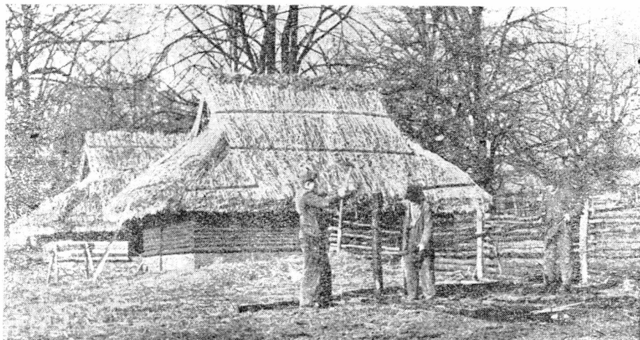
Zakład Doświadczalny Instytutu Zootechniki w Grodźcu Śląskim. Budowa fermy dla trzody chlewnej z żerdzi. Między żerdziami żużel lub plewy jęczmienne
