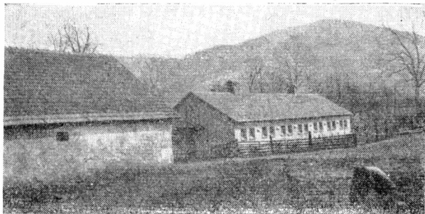
Chlewnia typowa na 5 loch w Spółdzielni Produkcyjnej Inwałd (pow. Wadowice). Mury z żużło-wapnia, obłożone od zewnątrz cegłą (połówkami) na kant. Grubość muru 40 cm. Chlewnia zimna, wilgotna
