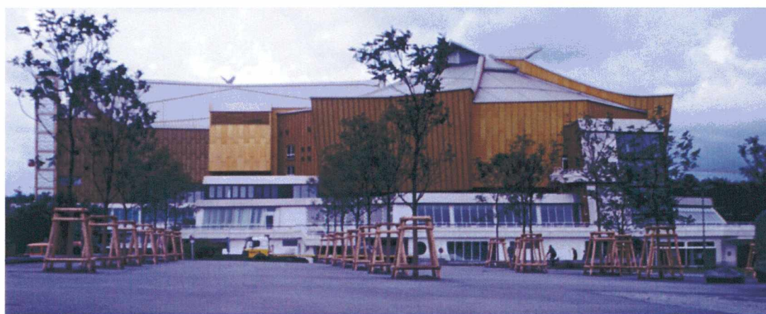
Rys. 108. Filharmonia w Berlinie - elewacja [fot. Elżbieta Trocka-Leszczyńska]
