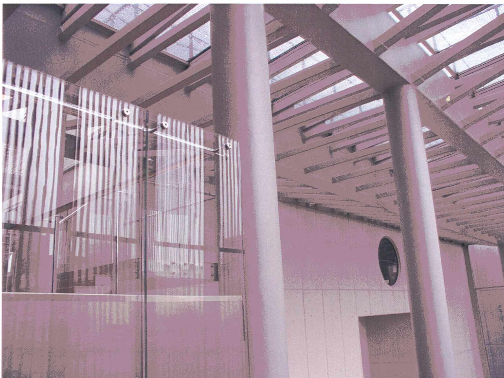
Rys. 260. Filharmonia w Łodzi – fragment konstrukcji szklanego dachu [fot. autorka]
