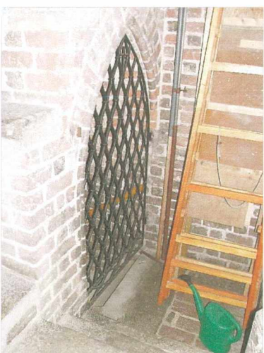
II. 251 WROCŁAW, kościół pw. Świętego Krzyża, portal w wieży pn do kościoła dolnego
