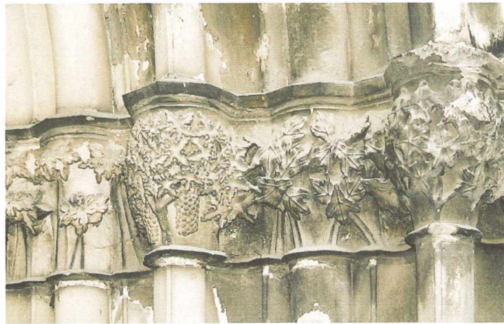
Głubczyce, portal południowy
