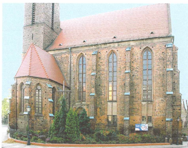
ŚRODA ŚLĄSKA, kościół franciszkański, elewacja północna
