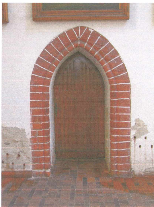
II. 24 BRZEG, kościół p.w. św. Mikołaja portal z nawy południowej do wieżyczki schodowej
