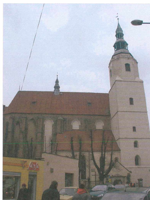
II. 40 DZIERŻONIÓW, kościół p.w. św. Jerzego, widok ogólny od północy
