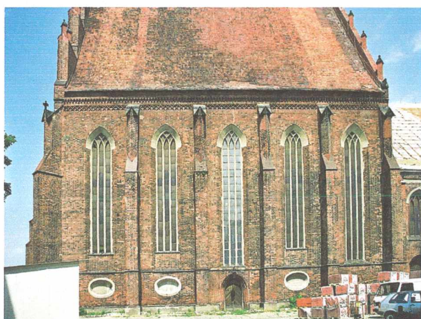
ŻARY, kościół p.w. Panny Marii, elewacja południowa
