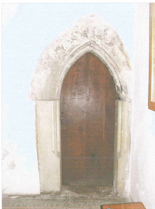
II. 207 WROCLAW, kościół pw. Najświętszej Marii Panny na Piasku, portal do wieżyczki schodowej
