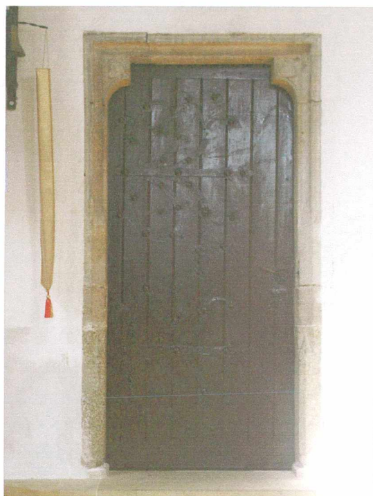
II. 147 STRZEGOM, kościół p.w. śś. Piotra i Pawła, portal z prezbiterium do zakrystii, widok
