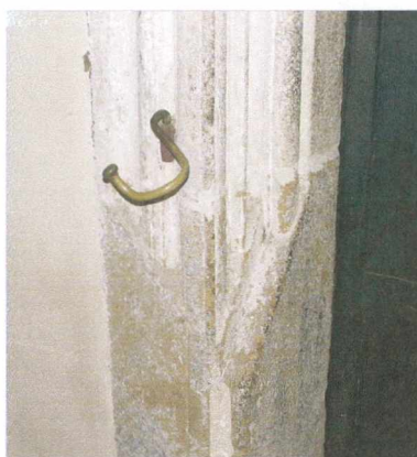
II. 75 JAWOR, kościół pw. św. Marcina, portal z prezbiterium do zakrystii, detal ościeża
