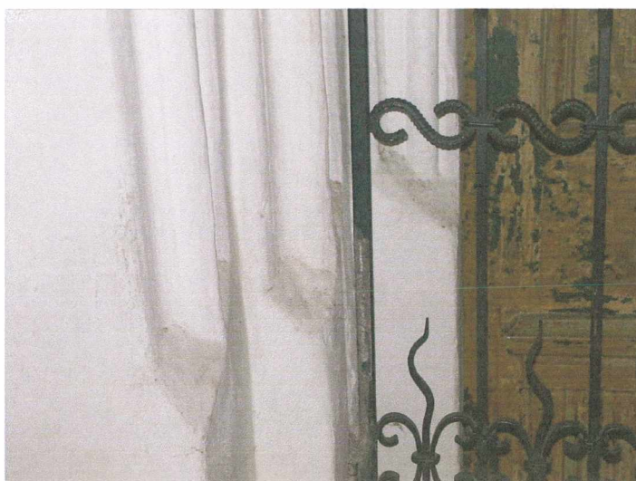
II. 44 DZIERŻONIÓW, kościół p.w. św. Jerzego, portal z kruchty północnej do nawy, detal osieźa
