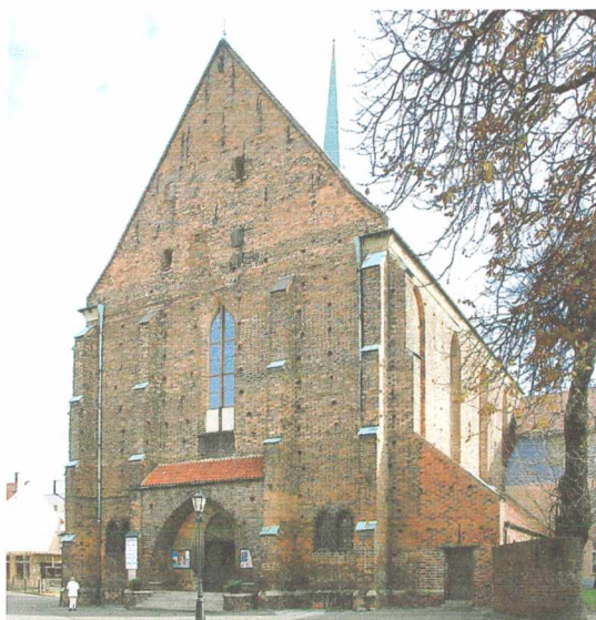
Środa Śląska, kościół franciszkański, elewacja zachodnia
