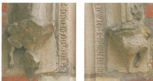
II. 105 LUBIN, Kaplica Zamkowa, portal północny, wsporniki
