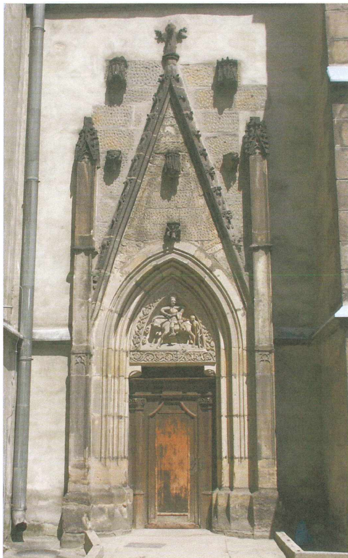
II. 66 JAWOR, kościół p.w. św. Marcina, portal od pd do prezbiterium, widok
