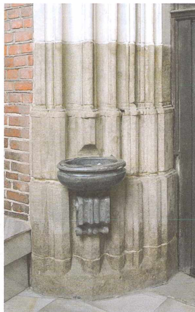
NYSA, kościół p.w. św. Jakuba, portal południowy do nawy
