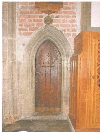
II. 187 WROCŁAW, katedra pw. św. Jana Chrzciciela, portal do wieżyczki schodowej wieży pn
