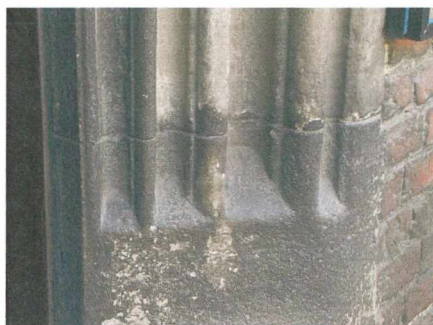
II. 163 ŚRODA ŚLĄSKA, kościół pw. Świętego Krzyża, portal zachodni, detal ościeża
