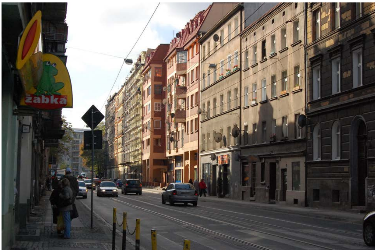
il. 05.13. Plomba przy ul. ks. Józefa Poniatowskiego 16-18 - widok od strony ulicy.
