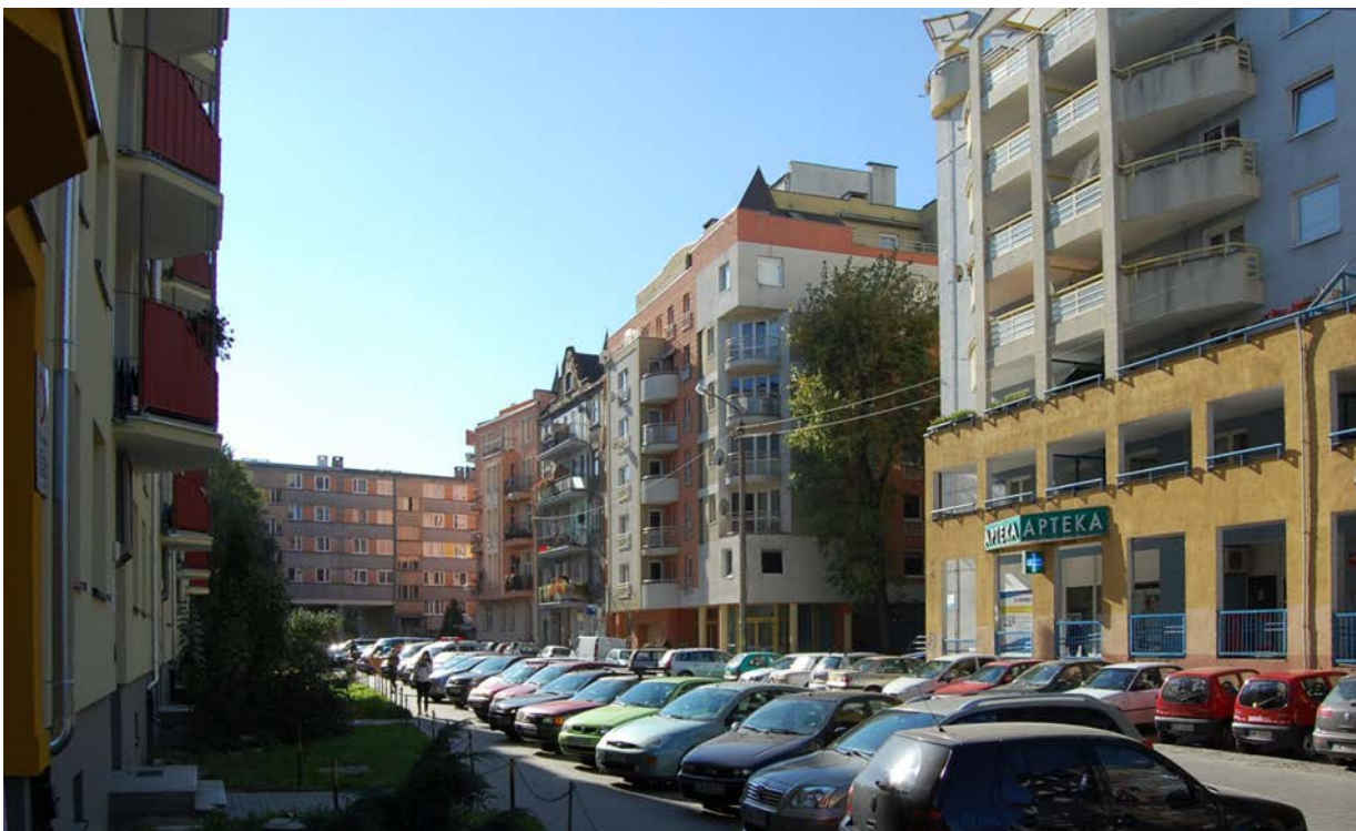
il. 04.18. Widok ul. Ciepłej - strona zachodnia proj. Juliusza Adama Modlingera i Marka Wołyńca (na pierwszym planie, ul. Ciepła 9-11) oraz Doroty Jarodzkiej-Śródki i Kazimierza Śródki - w głębi (ul. Ciepła 15-15a)
