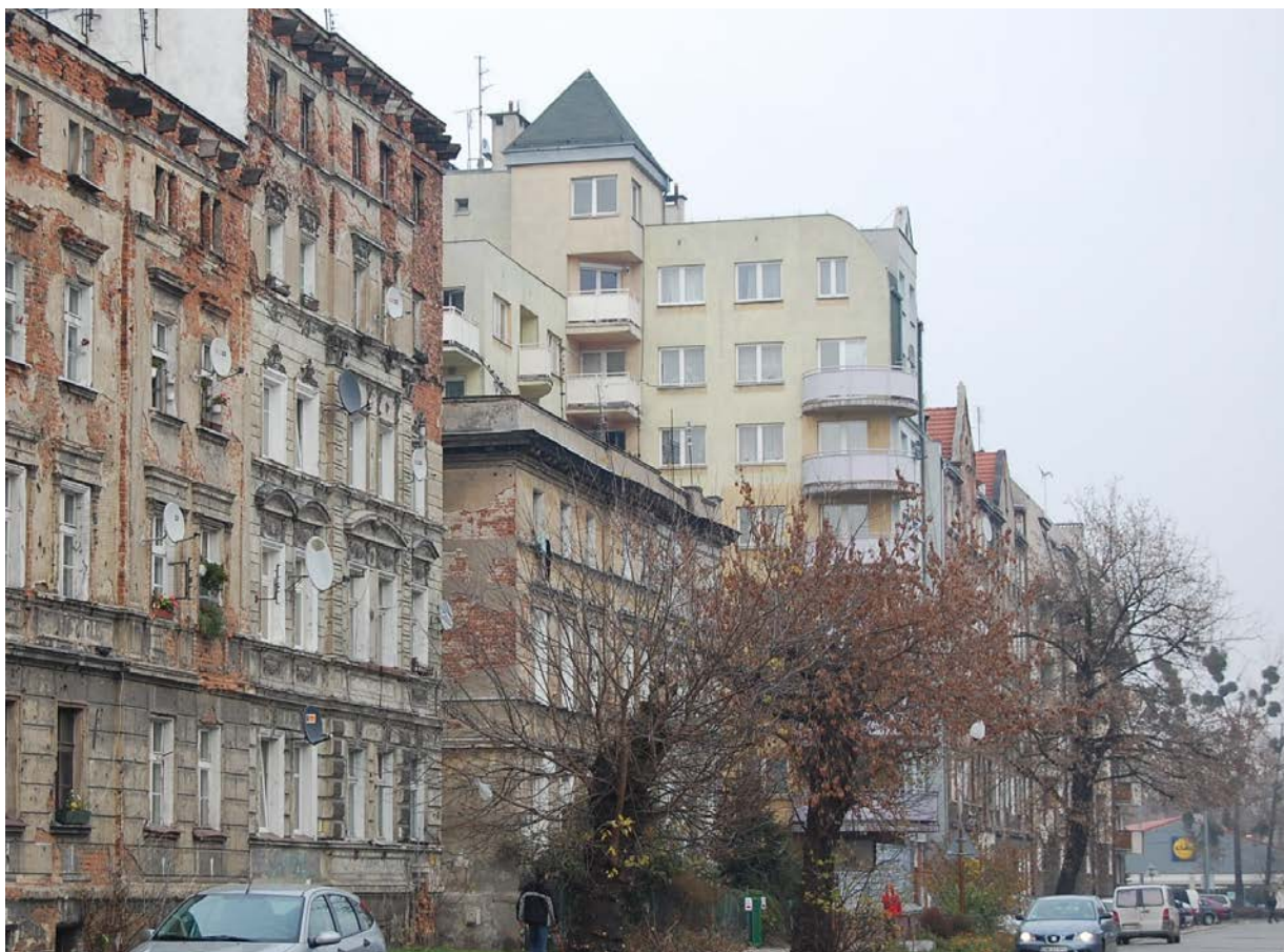
il. 04.16. Plomba proj. Kazimierza Gruny i Józefa Pałki w centralnej części pierzei ul. Św. Jerzego 15-15a
