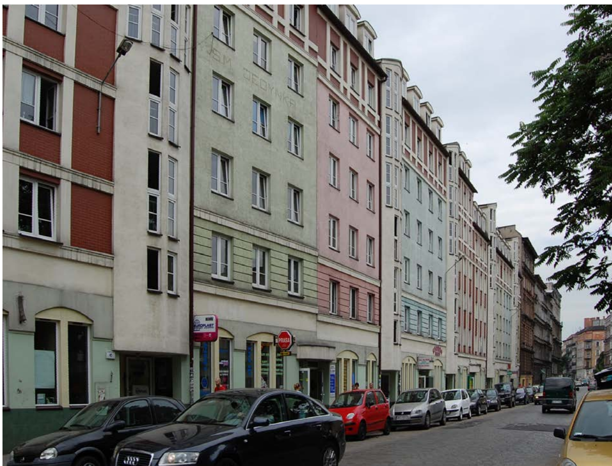
il. 05.28. Plomba przy ul. Henryka Pobożnego 10-18 i ul. Juliana Ursyna Niemcewicza 6, widok pierzei od strony ul. Henryka Pobożnego
