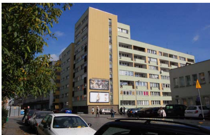
il. 02.8. Budynek przy ul. Benedyktyńskiej 14-18, stan obecny
