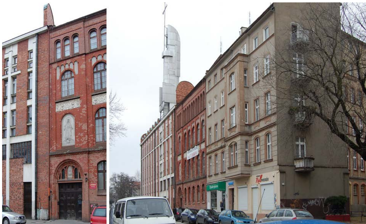
il. 05.5. Miejsce zespolenia nowej zabudowy z dawną kamienicą nr 18 (zdjęcie po lewej) oraz widok pierzei wschodniej ul. Wincentego Stysia od strony południowej.
