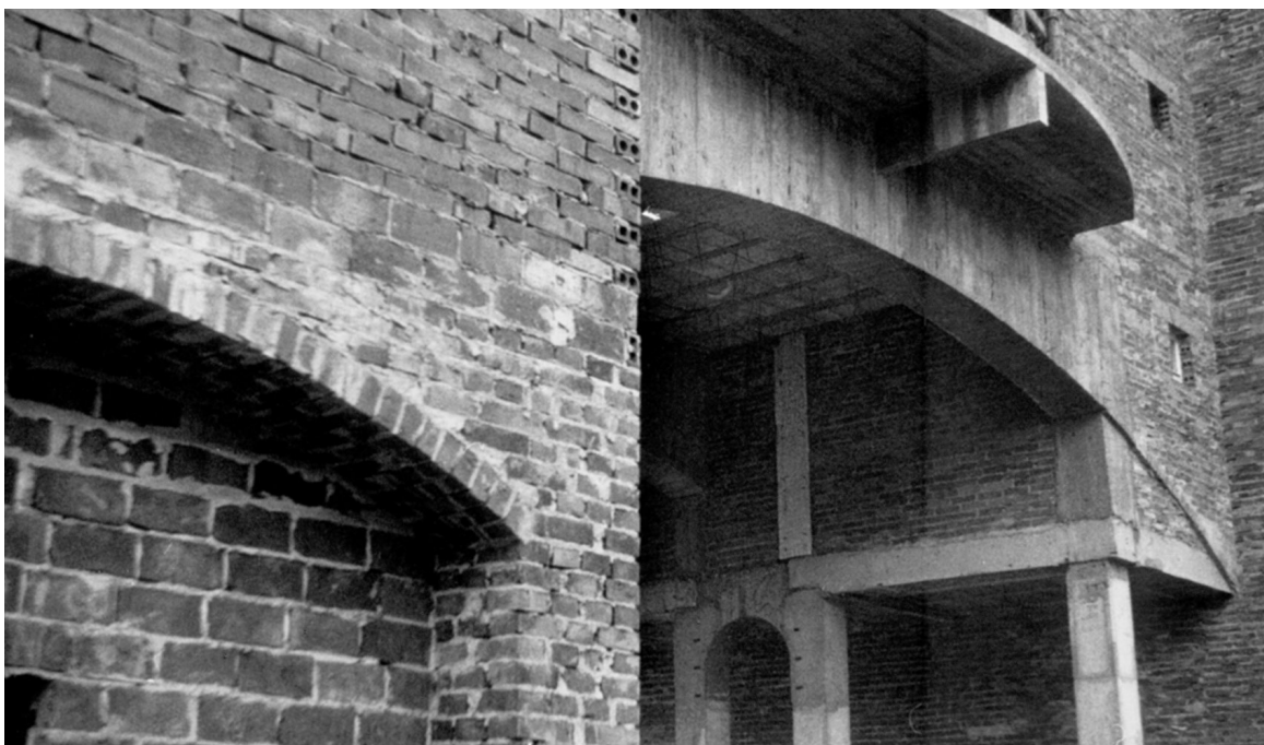
il. 05.20. Konstrukcja łuku bramnego plomby przy ul. gen. Józefa Hallera 22a-24a - stan surowy.
