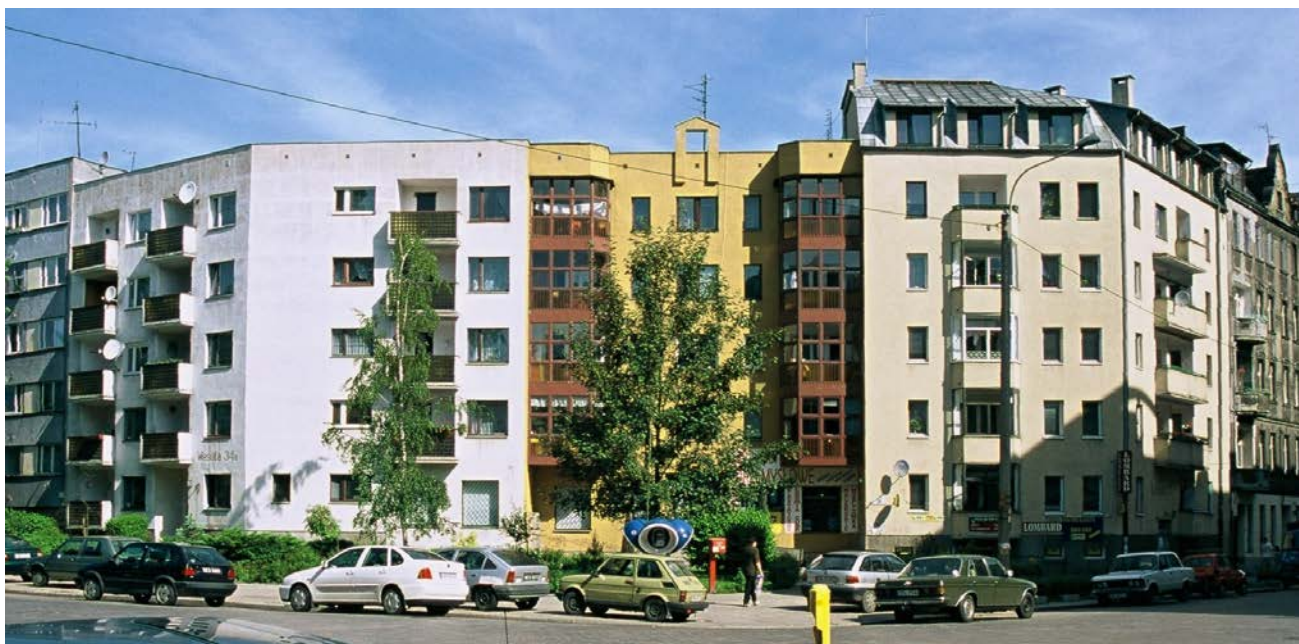
il. 04.19. Narożnik ulic Wesolej i Łódzkiej, budynek projektowany jako trzy odmienne segmenty, łączący zabudowę XIX w. z blokiem z lat 70., proj. Wacław Kamocki i Jarosław Świebocki.
