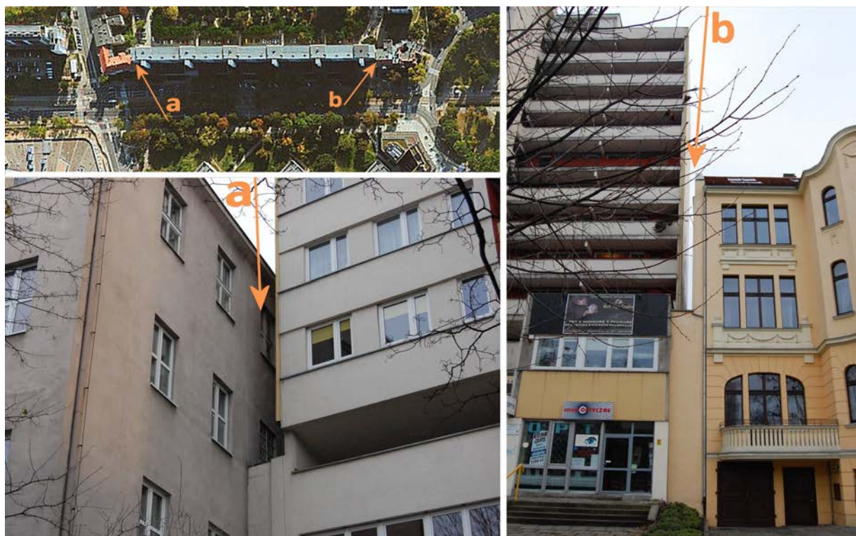
il. 03.1. Powiązania budynków galeriowych z lat 70. (proj. Julian Łowiński z zespołem) z zabudową sprzed 1945 r., ul. Powstańców Śl. 112 (z lewej, odcinek północny budynku) oraz nr 122 (z prawej, odcinek południowy).
