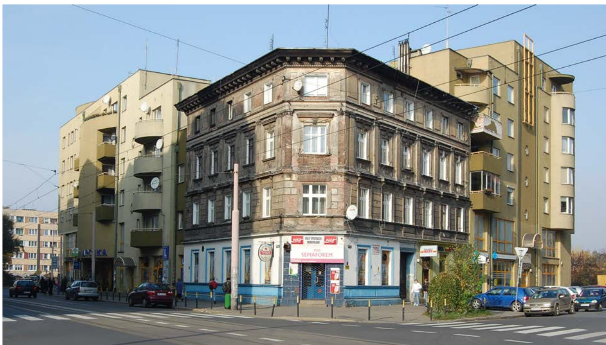
il. 04.14. Centralny skwer projektowany w tym miejscu w koncepcji z 1983 r. został zabudowany w latach 90. pomimo trudnej, niewielkiej i nieregularnej działki (plomby: ul. Gliniana 40-44, ul. Gajowa 21-23 projektu Mieczysława Kupczyka z 1997 r.)
