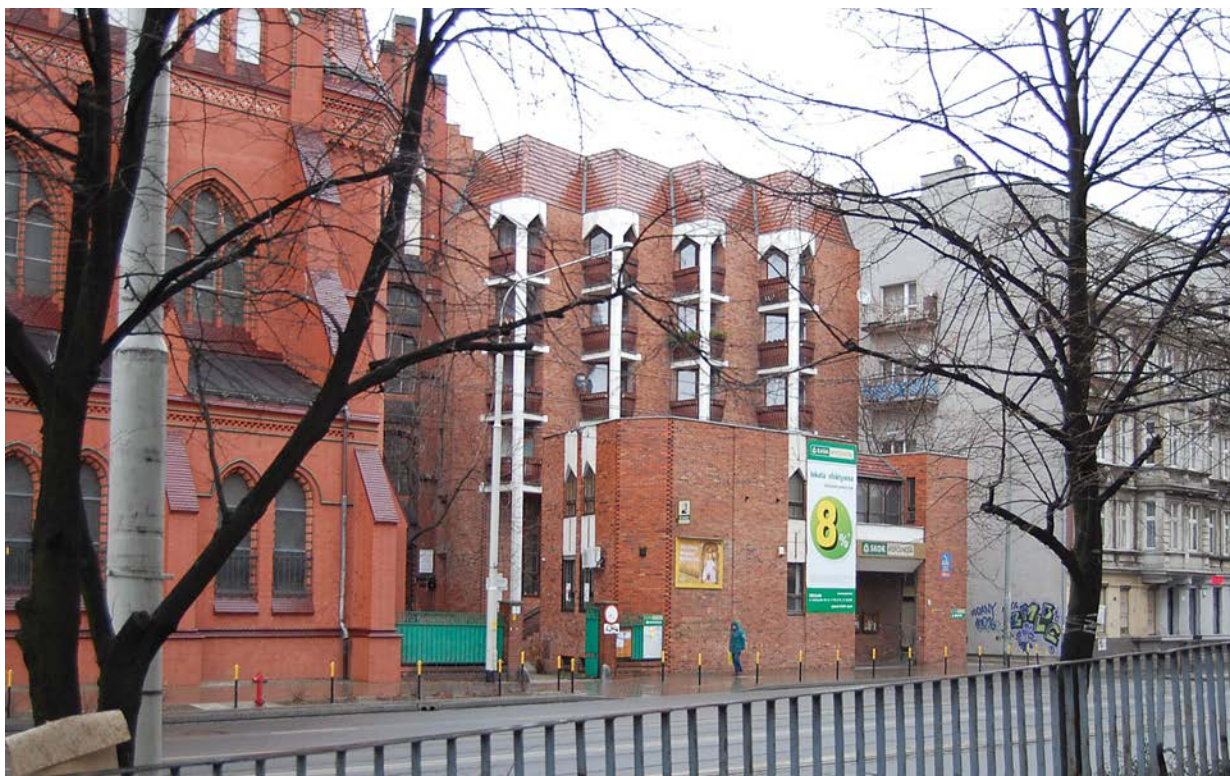
il. 05.8. Dom parafialny w linii zabudowy i wycofana z niej plomba - rozbudowa klasztoru, widok od strony ul. Grabiszyńskiej.
