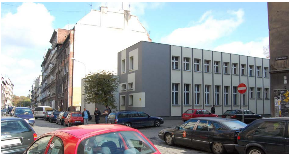
il. 04.31. Zabudowa narożnika na ul. Paulińskiej, róg ul. Ludwika Rydygiera
