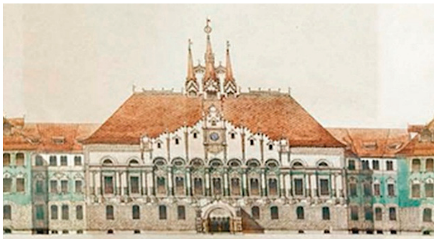
Rys. 1.3. Budynek Państwowego Uniwersytetu w Niżnym Nowogrodzie (1918), obecnie Instytutu Fizyki Stosowanej (ang. Institute of Applied Physics – IAP)
