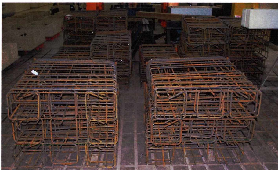
Rys. 4.7 Gotowe kosze zbrojeniowe przed umieszczeniem ich w deskowaniach
