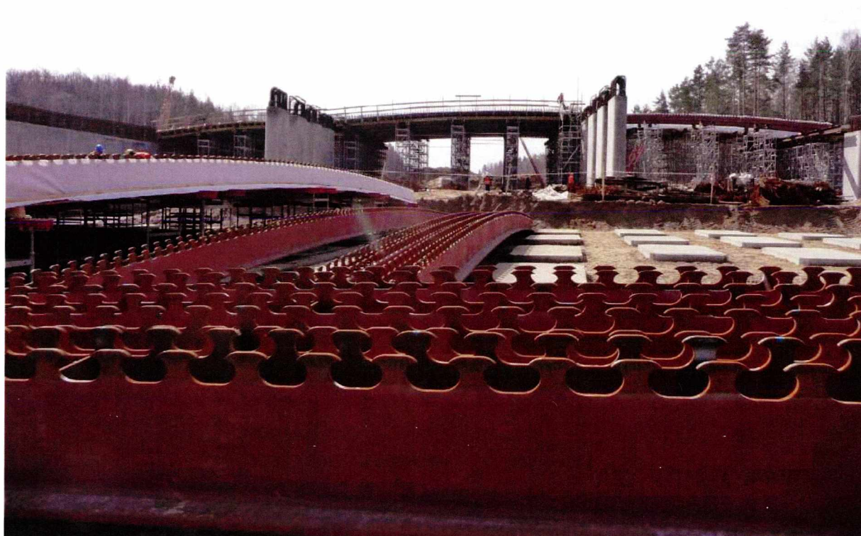
Rys. 2.28 Belki stalowe z łącznikami MCL przed wbudowaniem w konstrukcję przejścia dla zwierząt PE4 nad drogą S7
