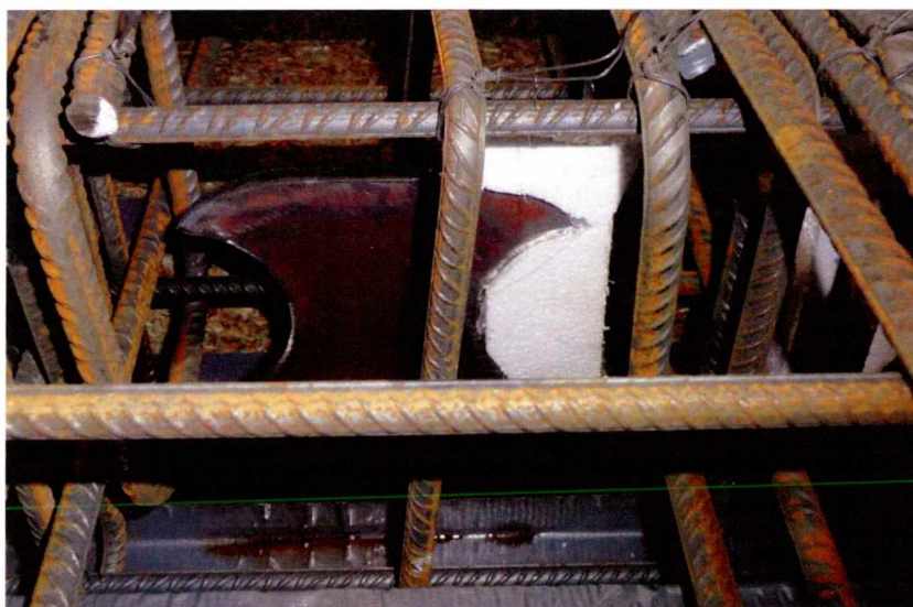
Rys. 4.40 Przyklejony styropian na powierzchni czołowej łącznika od strony działania siły ścinającej
