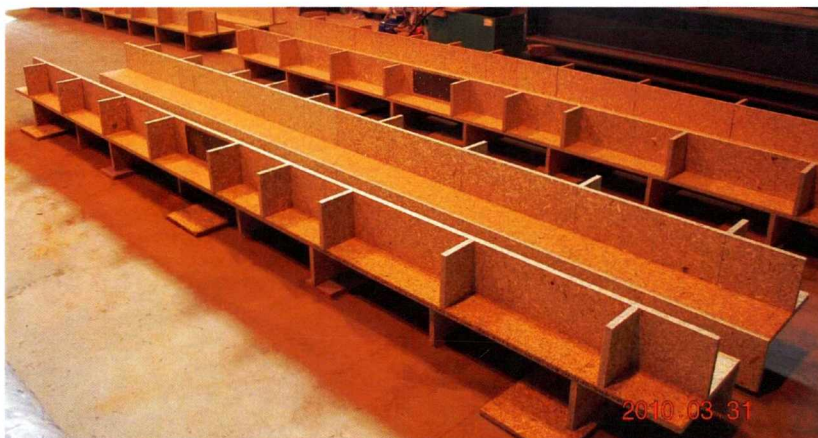
Rys. 4.38 Deskowania belek B1S oraz B2S
