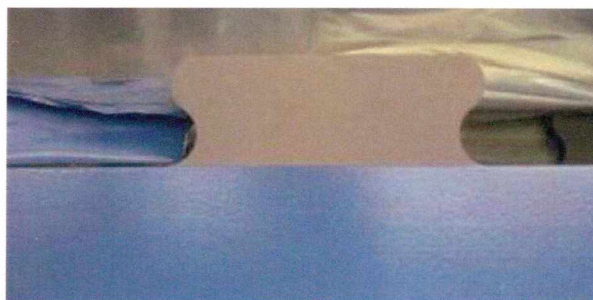
Rys. 2.13 Łącznik PZ wiaduktu w Pöcking [33]
