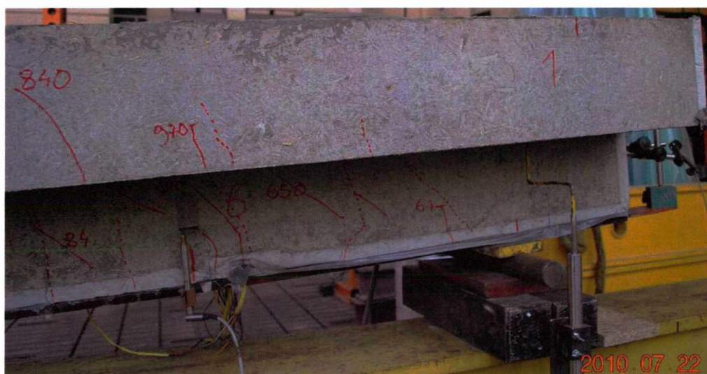
Rys. 4.65 Zarysowanie środka betonowego w miejscu pracujących łączników po zniszczeniu belki
