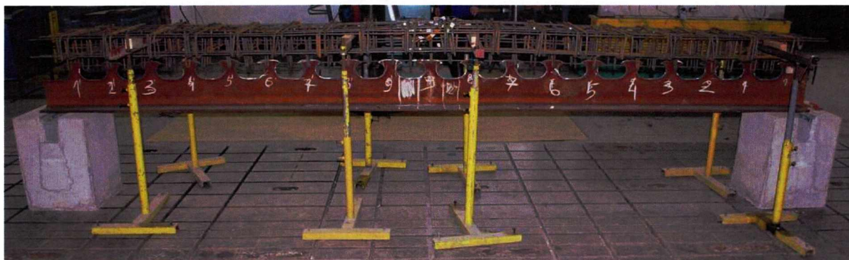
Rys. 4.39 Prefabrykowany kosz zbrojeniowy nad belką B1S
