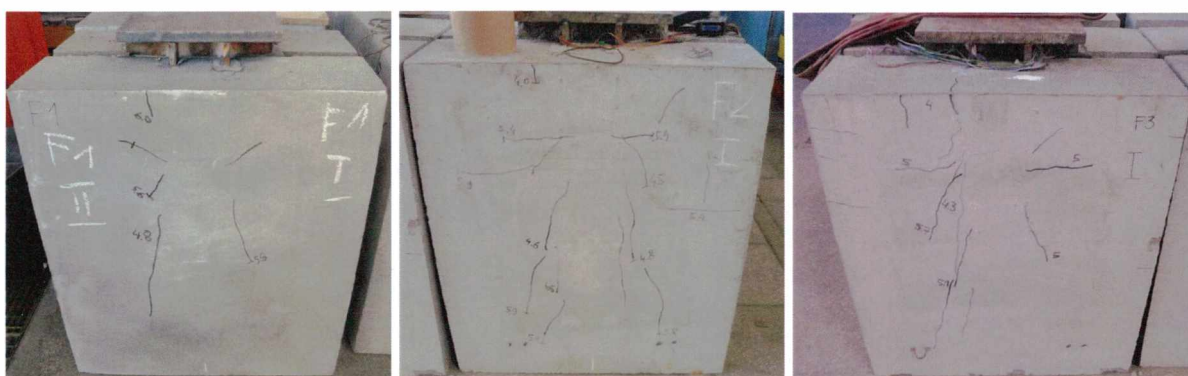
Rys. 4.24 Układ rys na płytach betonowych elementów (od lewej) F/1, F/2 i F/3
