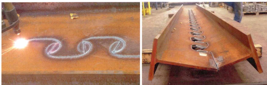
Rys. 4.33 Cięcie belki B1S palnikiem acetylenowo – tlenowym (po lewej) oraz belka po przecięciu, ale przed rozdzieleniem otrzymanych części (po prawej)
