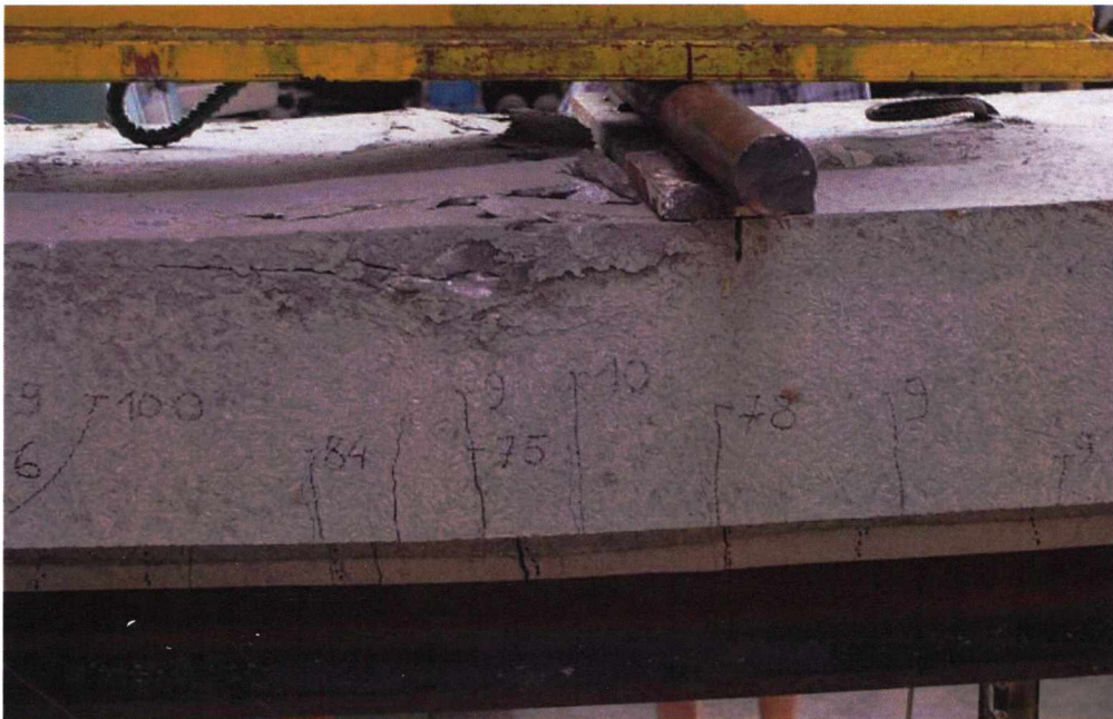
Rys. 4.58 Zarysowania płyty betonowej w miejscu przyłożenia siły skupionej z siłownika (przy rysach podano wartość siły)
