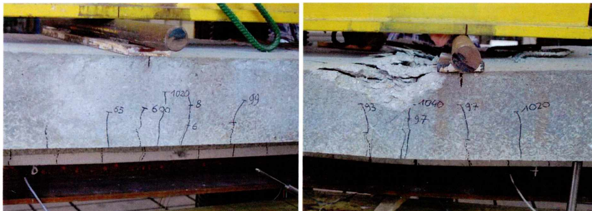
Rys. 4.52 Zarysowania płyty betonowej w miejscu przyłożenia sił skupionych z siłownika (przy rysach podano wartość siły)
