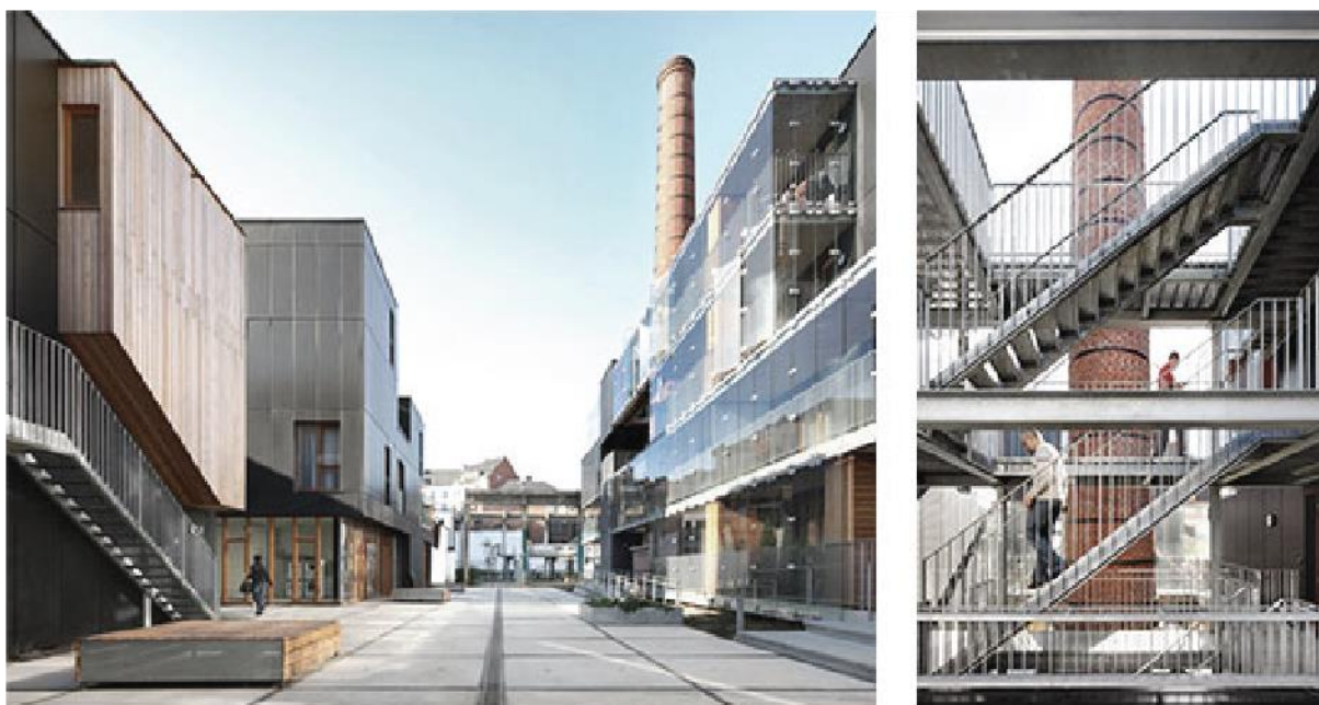
Rysunek 18. Dokumentacja fotograficzna budynku Savonnerie Heymans w Brukseli.
