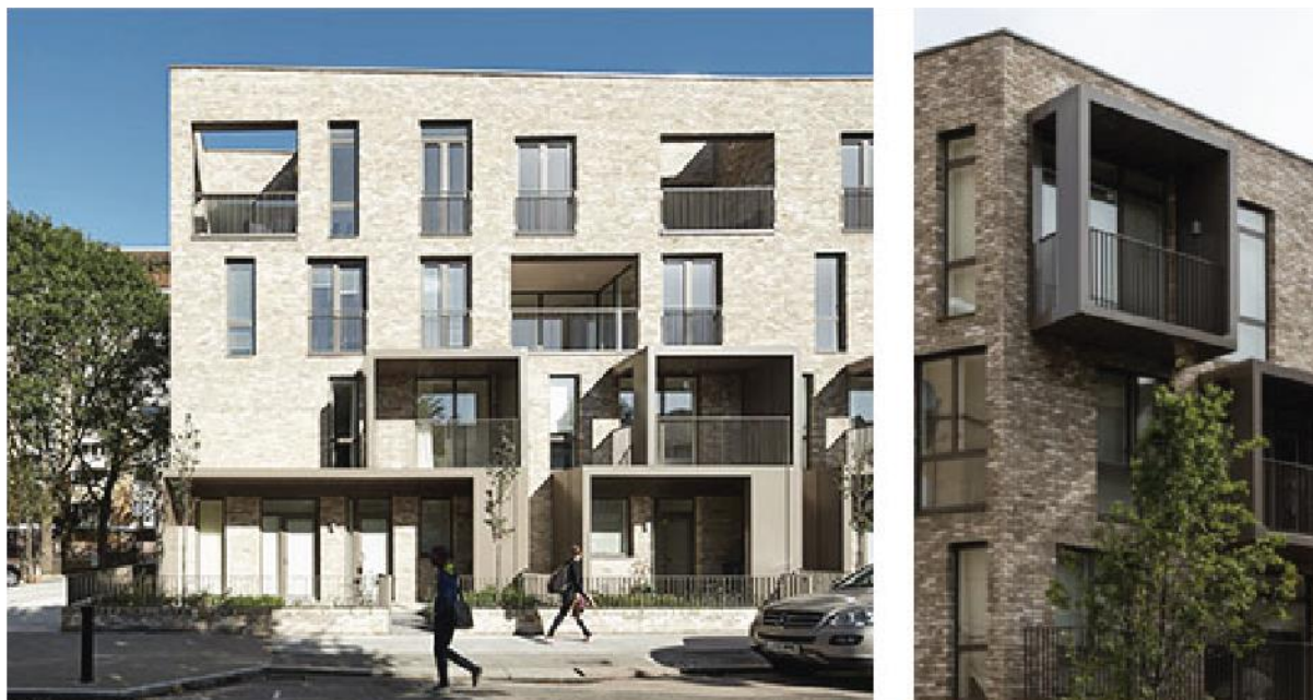
Rysunek 3. Dokumentacja fotograficzna budynku Ely Court w Londynie.
