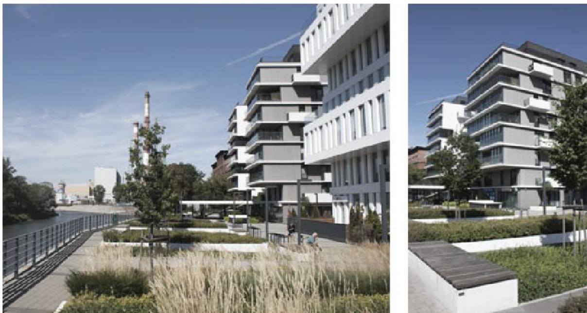
Rysunek 30. Dokumentacja fotograficzna budynku Kurkowa 14 we Wrocławiu.
