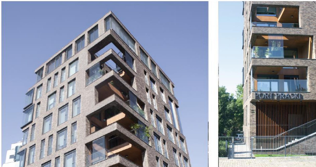
Rysunek 63. Dokumentacja fotograficzna budynku Latarnia w Warszawie [fotografia autora].
