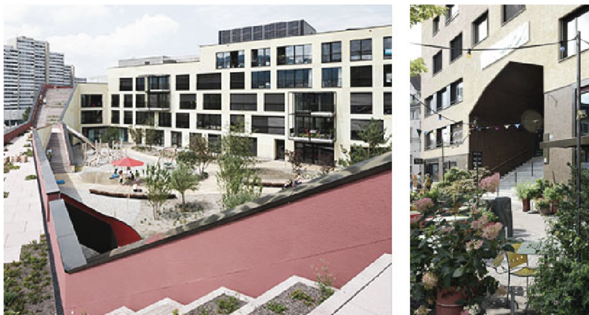
Rysunek 27. Dokumentacja fotograficzna budynku Genossenschaft Kalkbreite z Zurycha.
