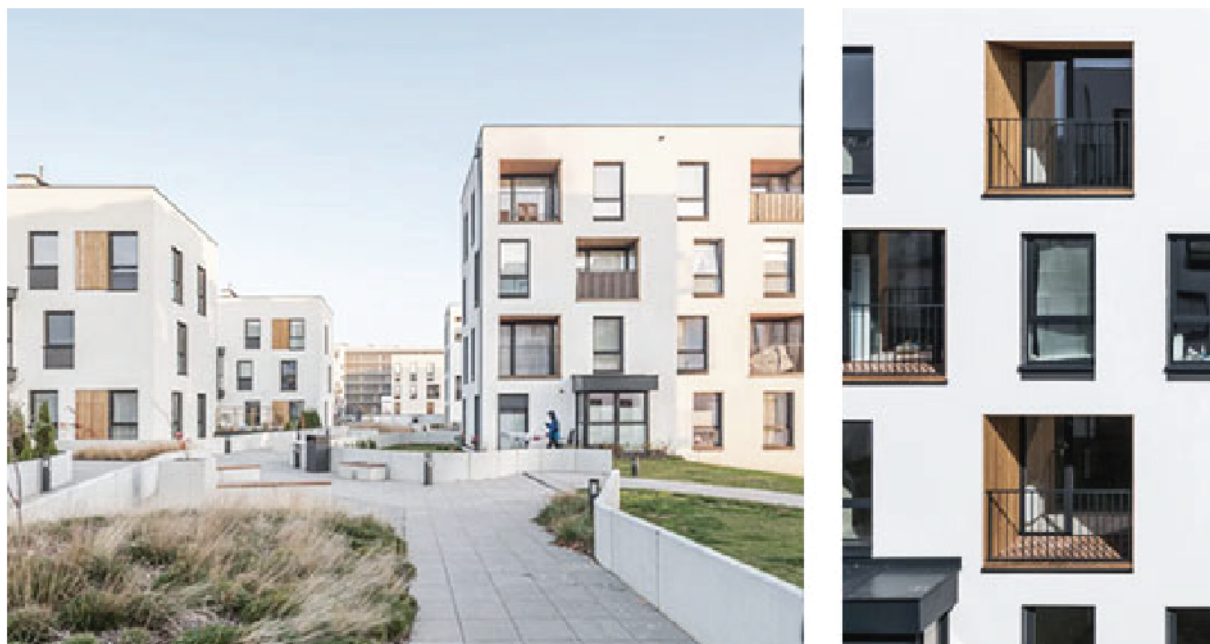
Rysunek 3. Dokumentacja fotograficzna budynku osiedla Atmosfera we Wrocławiu [źródło fotografii: www.archit.pl dostęp: 23.11.2018].
