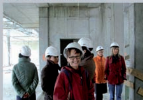
Wizyta na budowie
