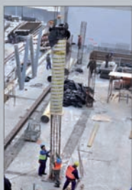
Montaż podpór, wrzesień 2010 r.
