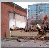
Usuwanie ostatnich fragmentów starej zabudowy 20 lipca 2009 r.
