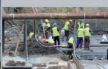
Budowliwcy w akcji, październik 2009 r.
