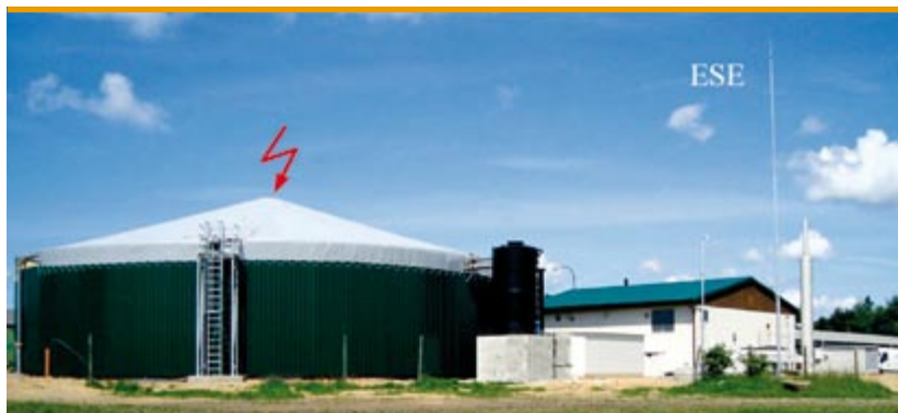
Stacja biogazu w Malsicach w Czechach. Miejsce uderzenia pioruna zaznaczono czerwoną błyskawicą, napis ESE wskazuje położenie masztu z głowicą aktywną. Zaadaptowane ze strony http://www.enwitec-biogas.cz/reference.html
