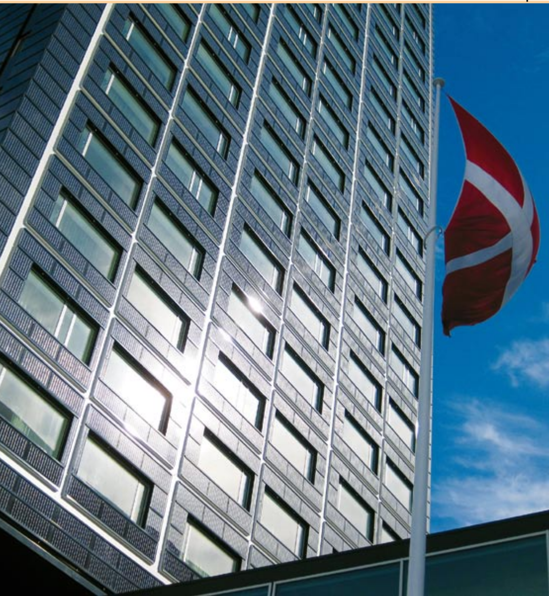
Ogniwia fotowoltaiczne na elewacji budynku hotelu Copenhagen Crowne Plaza
