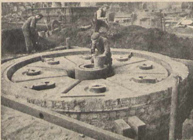
Rys. 3. Forma do odlewu głównego koła jednej z przekładni pomiędzy turbiną a śrubą napędową. Ciężar odlewu: 80 tonn.
