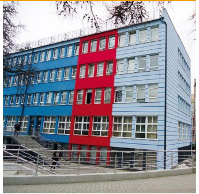
Budynek C-3, 2012 r.
