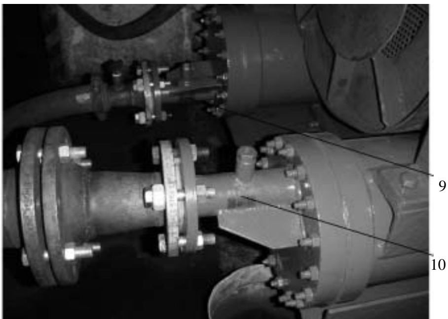
Rys. 13.11. Krońce: doprowadzający (9) i odprowadzający (10) wodę ze skraplacza chłodziarki DV-290
