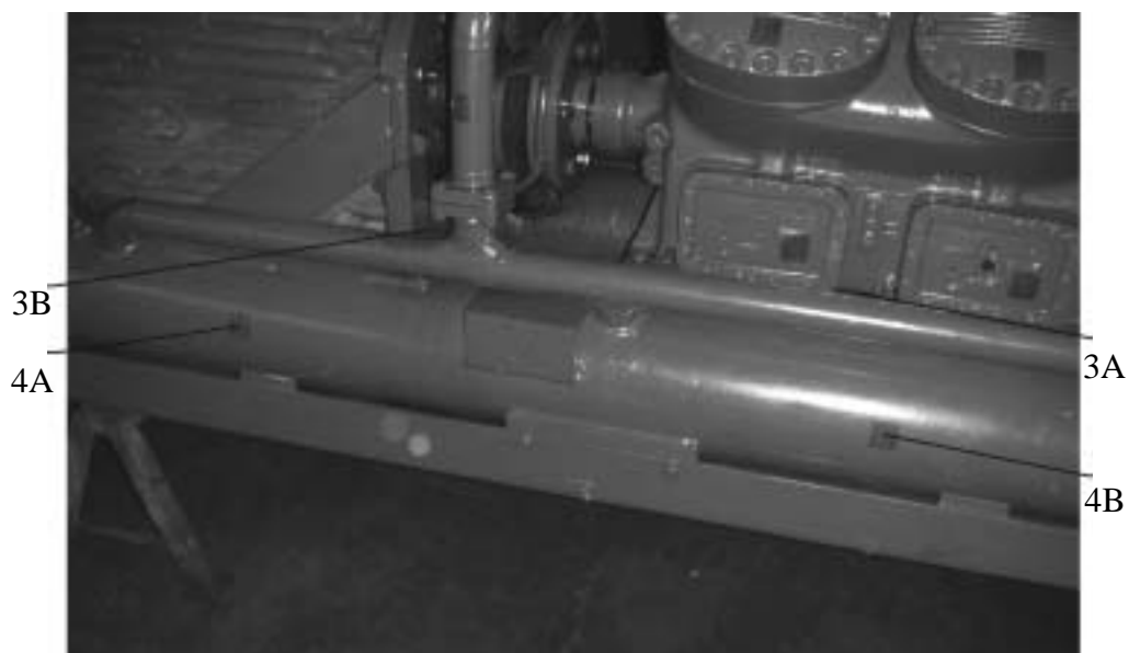
Rys. 13.8. Skraplacz z odprowadzeniem wody (4A, 4B) oraz doprowadzeniem wody (3A, 3B) chłodziarki DV-290
