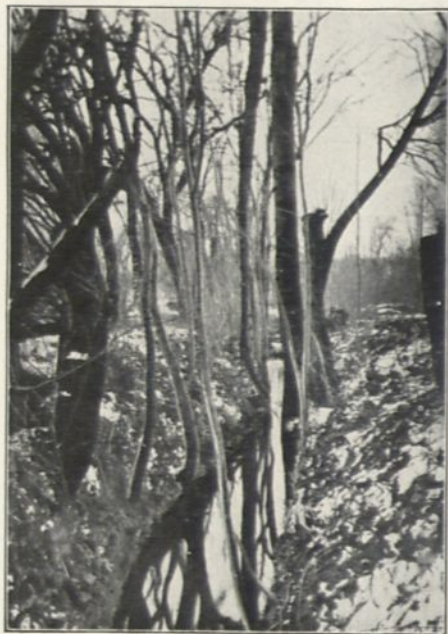
Verwachsener Vorflutgraben vor der Räumung.
