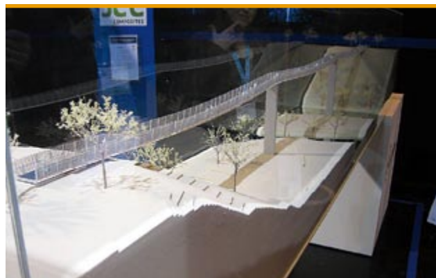
Makieta najdłuższego na świecie kompozytowego mostu wiszącego
