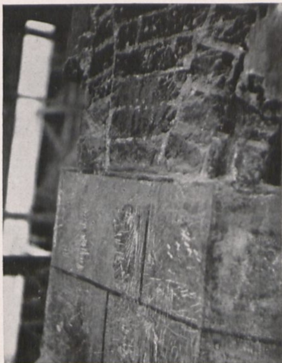
Abb. 17. Ostpfeiler der basilikalischen Südarkade mit beiderseitigen Bogenanfängen von Norden.
