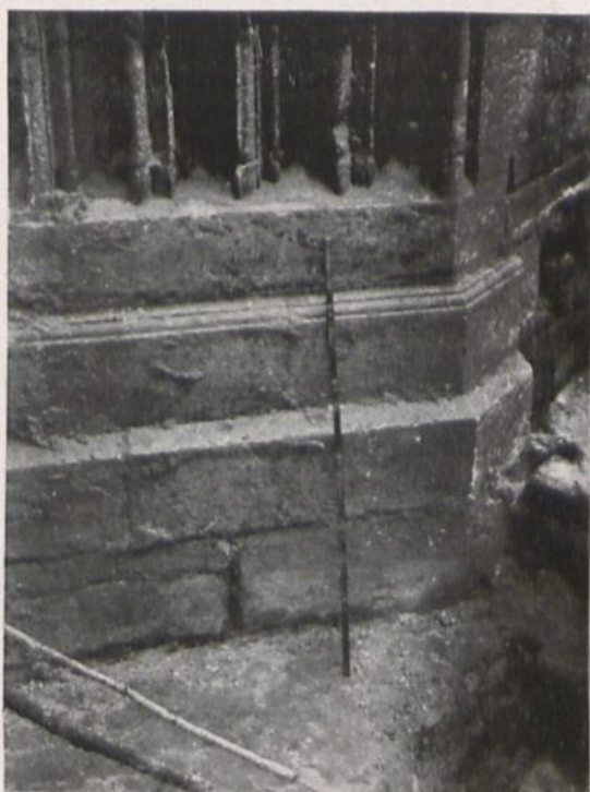
Abb. 16. Sockel am Turmportal ausgegraben.
