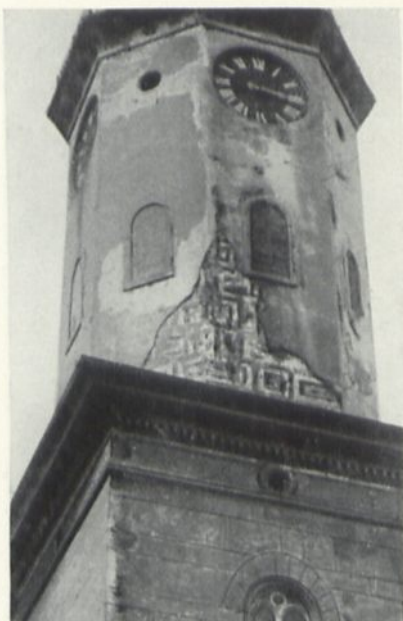
132 Habelschwerdt, Rathausurm mit Resten von Sgraffitoputz
