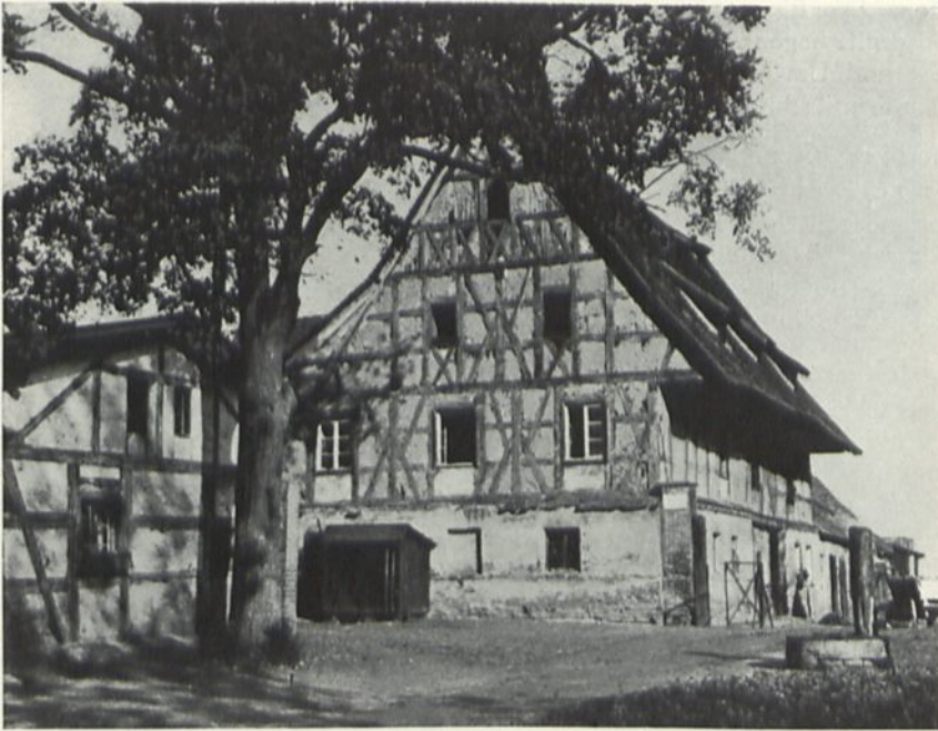
140 Opperau. Fachwerkhaus vor der Instandsetzung
