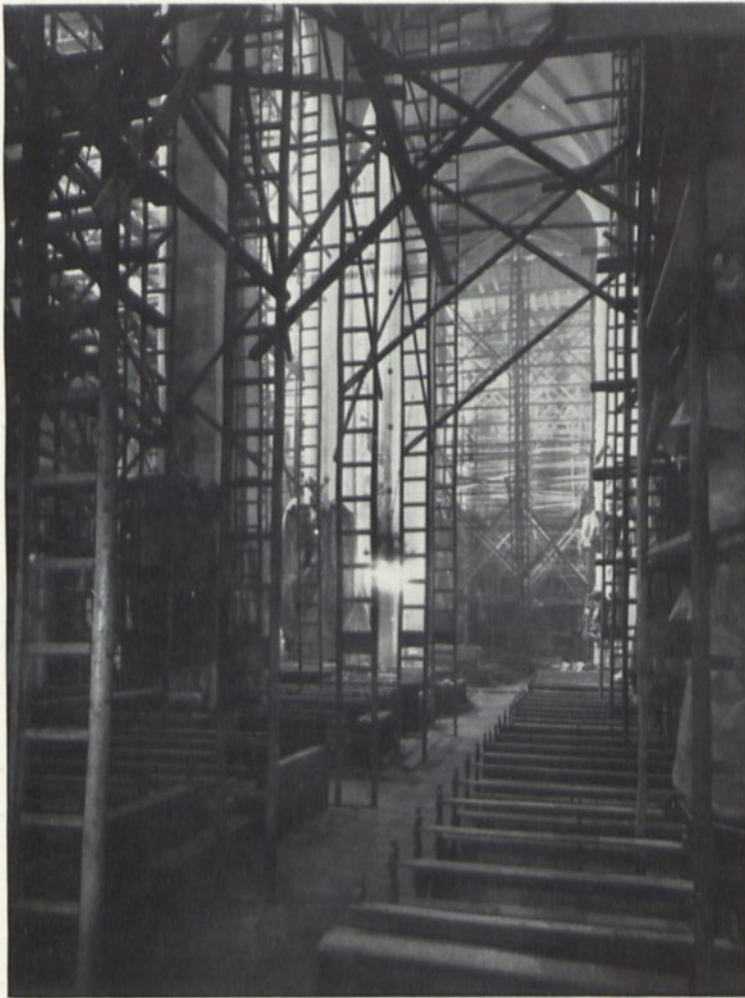
117 Breslau, Dorotheenkirche. Inneres während der Instandsetzung
