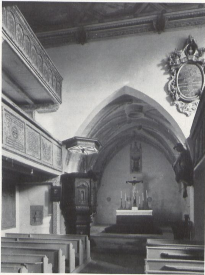
168 Zedlitz, ev. Kirche nach der Instandsetzung
