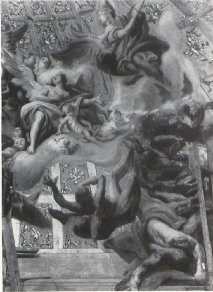
73 Breslau, Kurfürstenkapelle Kuppelfresko, Engelsturz, vor der Instandsetzung
