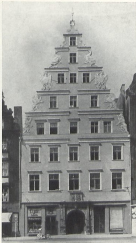
109 Breslau, Greifenhaus nach der Wiederherstellung
