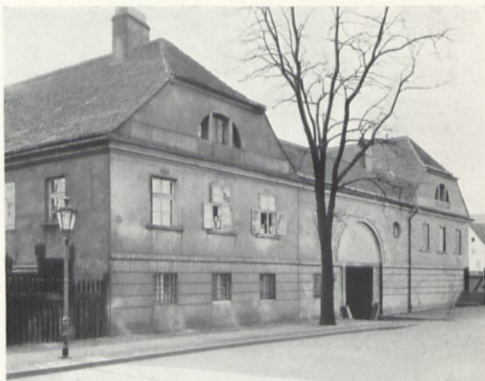
110 Breslau, Salzstraße 54 vor dem Abbruch
