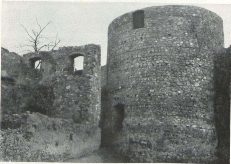
5 Zeisburg. Berchfrit nach der Instandsetzung
