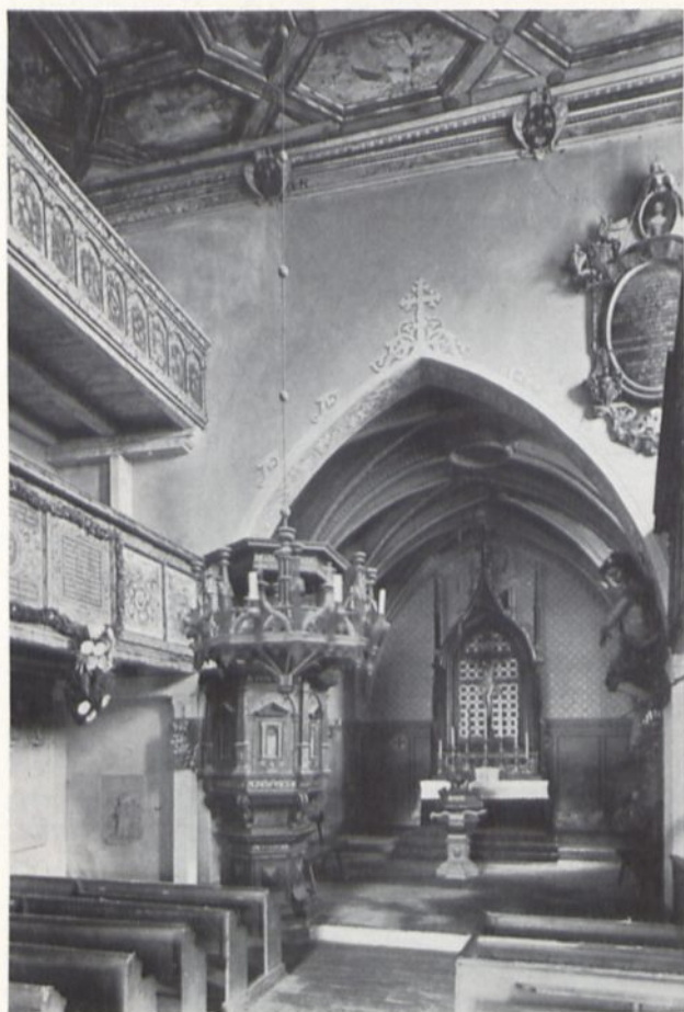
167 Zedlitz, ev. Kirche vor der Instandsetzung
