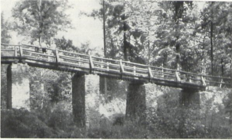
4 Zeisburg. Zugangsbrücke zur Burg nach der Instandsetzung
