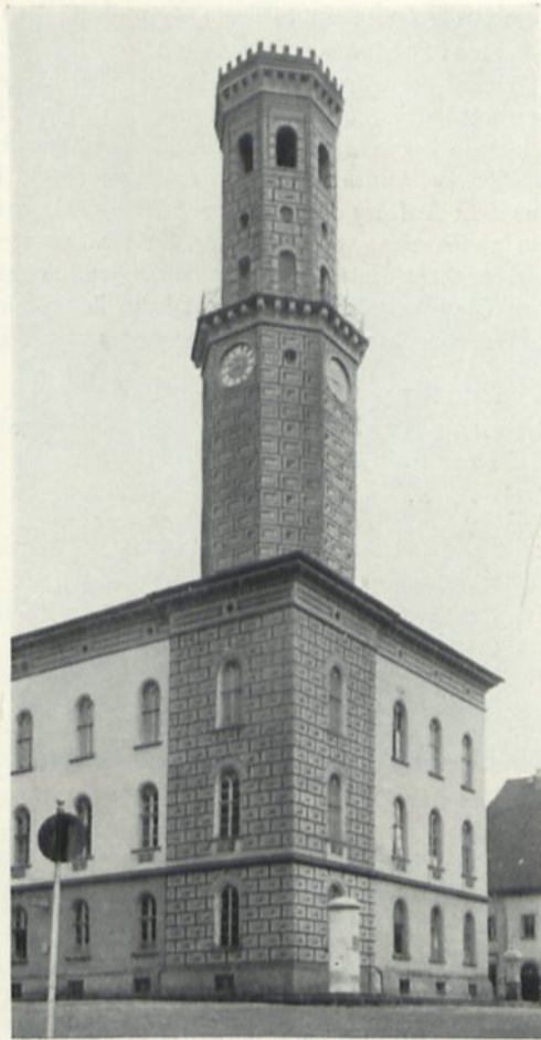
135 Habelschwerdt. Rathaus nach der Instandsetzung
