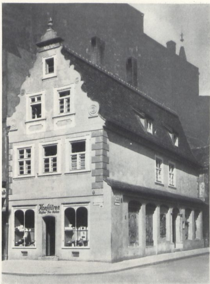
107 Breslau, Nikolaistraße 40 nach der Wiederherstellung
