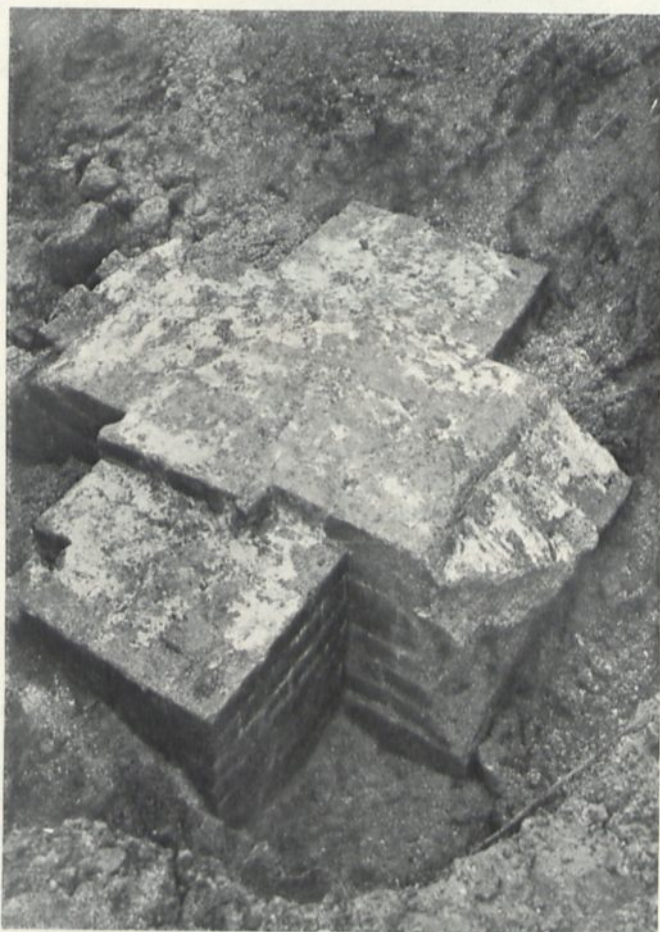
125 Breslau, ehemaliges Vinzenzkloster auf dem Elbing. Kreuzpfeiler mit den Ansätzen der Bogenwiderlager
