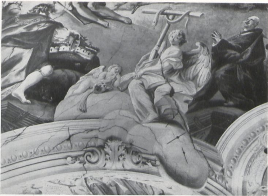
80 Wahlstatt, Klosterkirche Einzelheit des Deckenbildes über dem Langhaus vor der Instandsetzung
