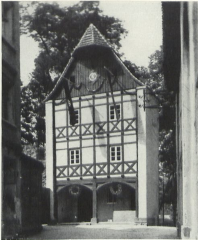
130 Frankenstein. Stadtmauerturm als Heim der Technischen Nothilfe
