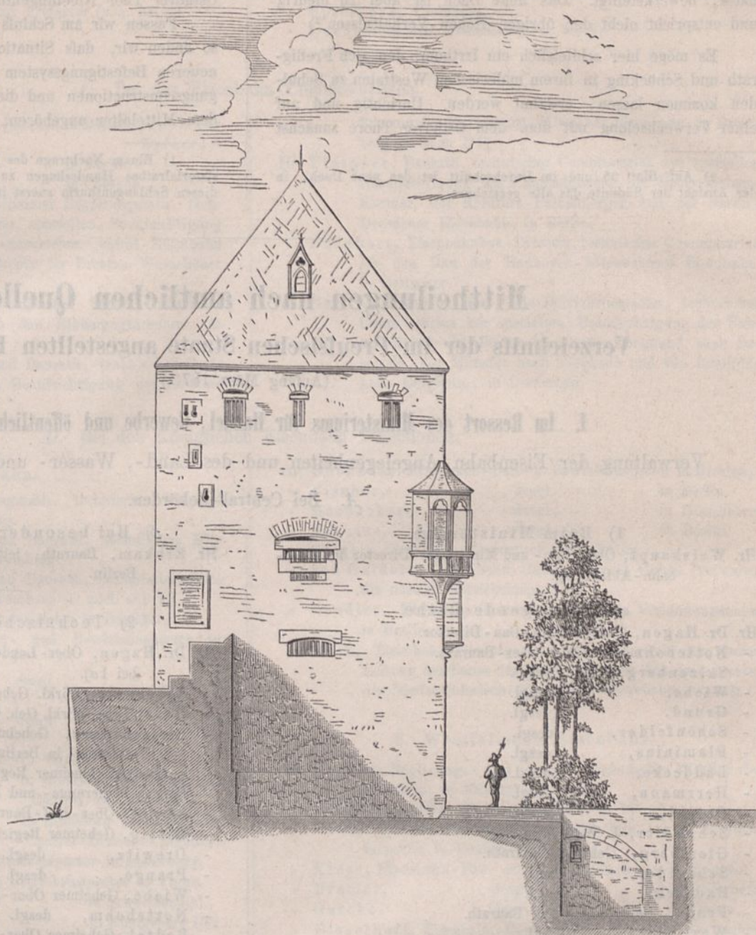
Ansicht der Südseite.
