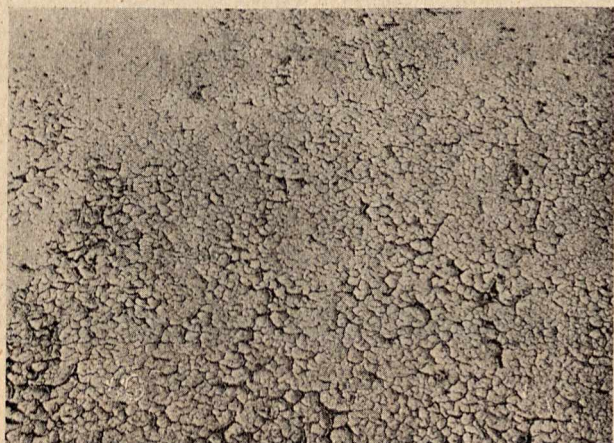
Rys. 3. Zeschnięta skorupa na filtrze wodociągowym.
