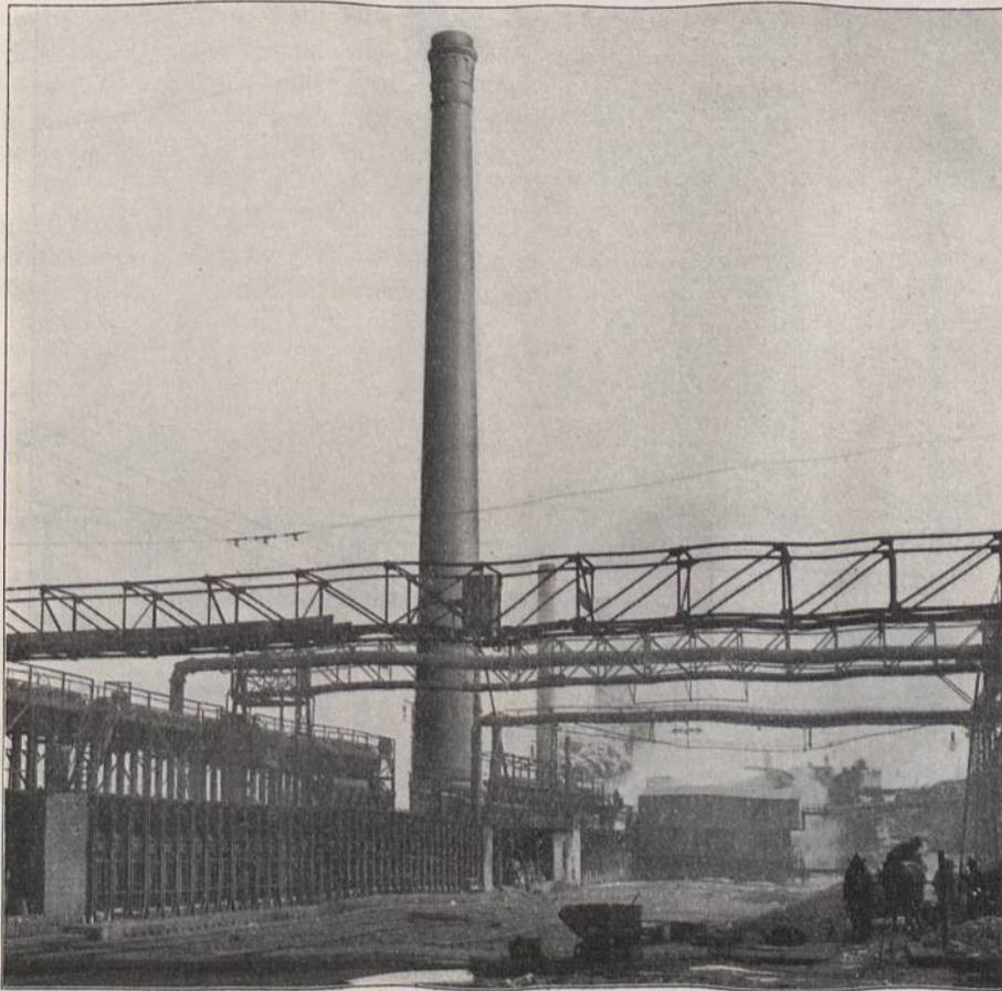
Fig. 18. Ofenbeschickung ohne Absaugevorrichtung, Kokerei Bahnschacht.
