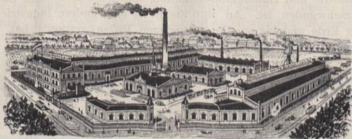
Die in Eisenkonstruktion erbaute 85 m lange und 24 m breite Montagehalle ist außergewöhnlich hoch und von allen Seiten reichlich mit hohen Lichtfenstern versehen. Der Antrieb der Werkzeugmaschinen erfolgt durchweg elektrisch.
