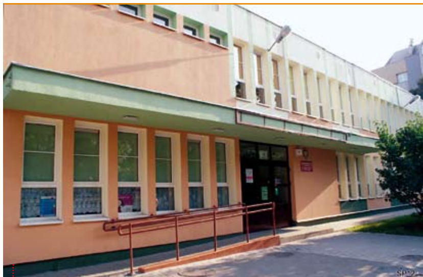
W tym budynku obecnej SP nr 12 ma docelowo działać Zespół Szkół Akademickich PWr. Rektor uczelni zapowiada też gruntowną modernizację tego obiektu
