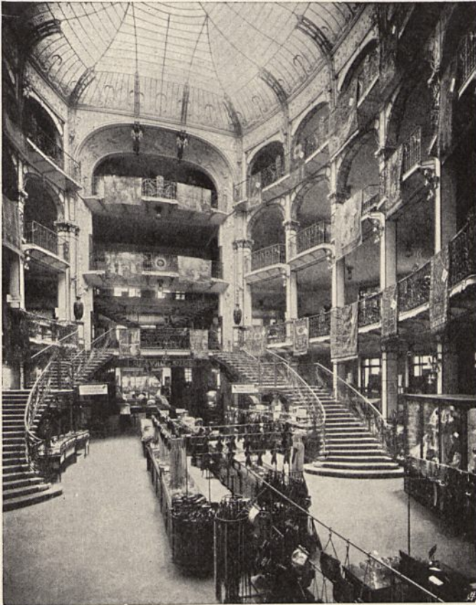
Abb. 669. Warenhaus Gerngroß in Wien. Innenraum.
