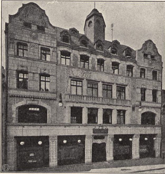
Abb. 630. Gebäude von Stotz & Co. in Mannheim.
