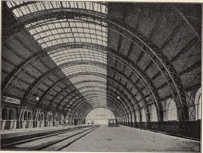
Abb. 495. Bahnhof Alexanderplatz in Berlin. Bahnsteighalle.
