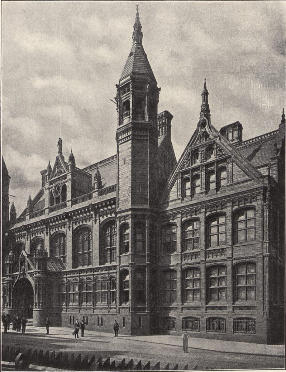
Abb. 742. Gerichtsgebäude in Birmingham.
