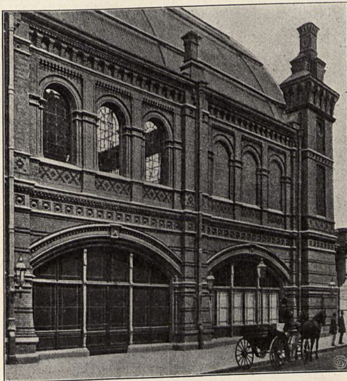
Abb. 494. Bahnhof Friedrichstraße in Berlin.
