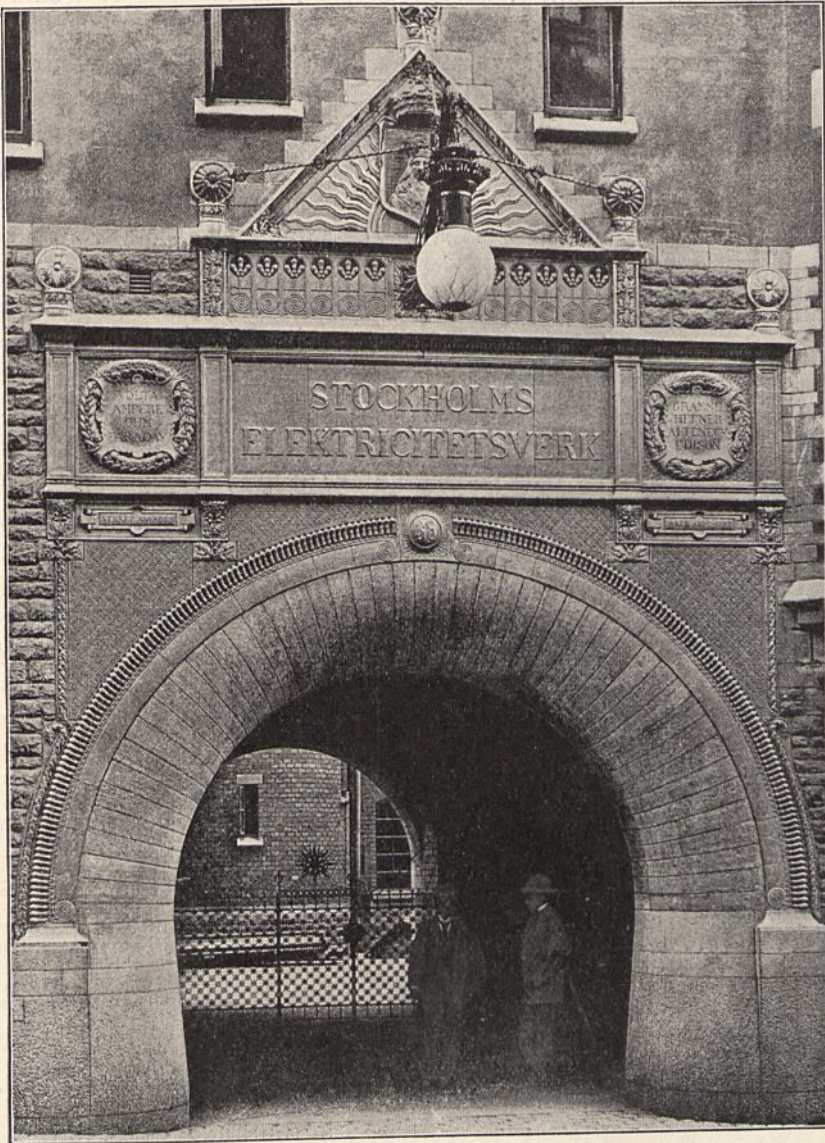
Abb. 861. Städtisches Elektrizitätswerk in Stockholm. Portal.
