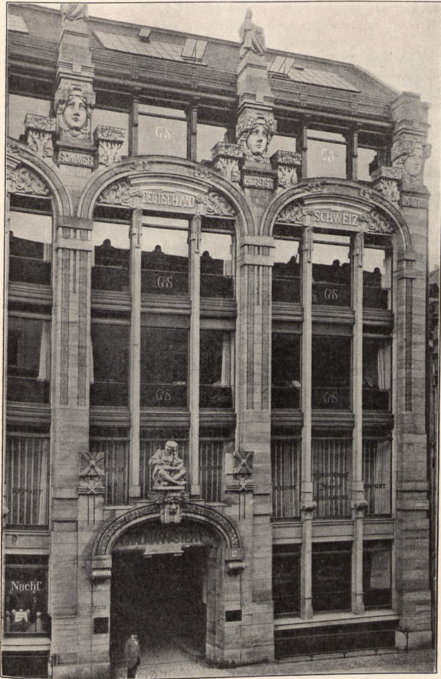
Abb. 465. Geschäftshaus Mohrenstraße 36 in Berlin.
