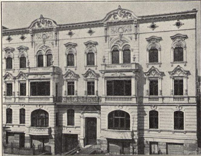
Abb. 481a. Wohnhaus Brückenallee 23 in Berlin.
