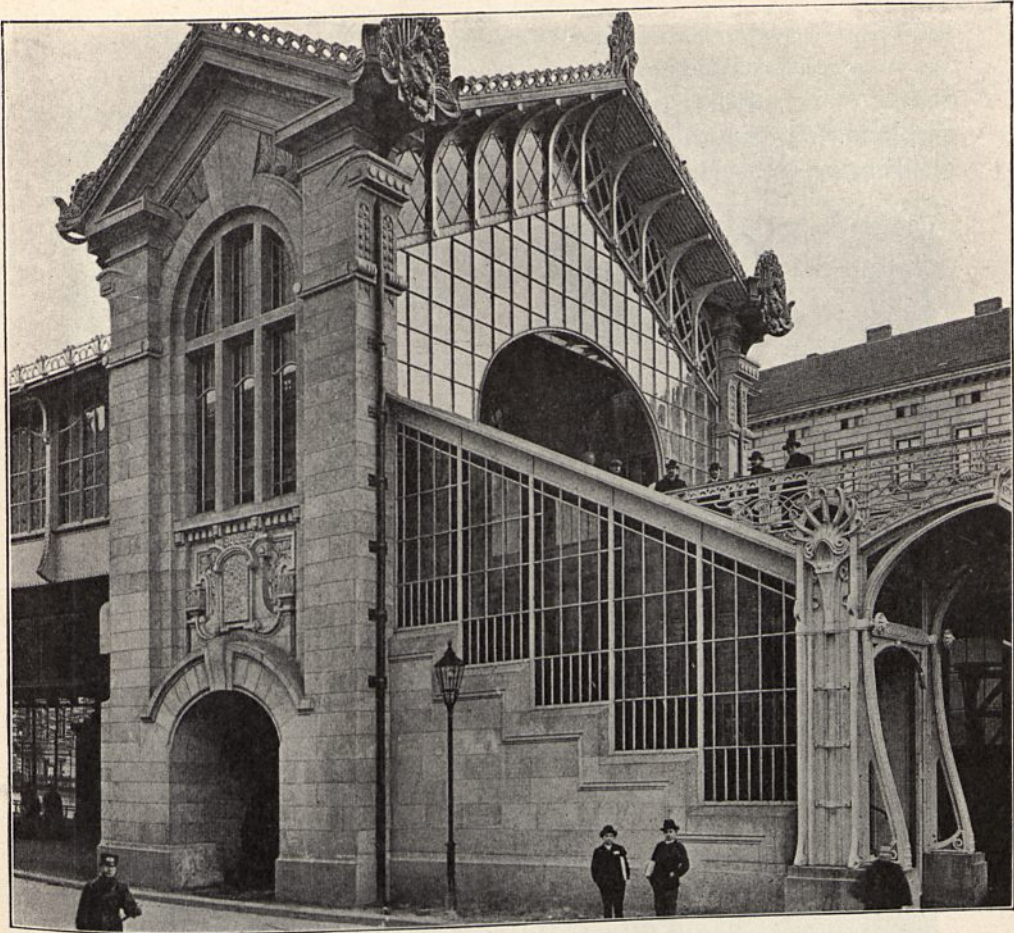
Abb. 496. Bahnhof Bülowstraße der Hochbahn in Berlin.
