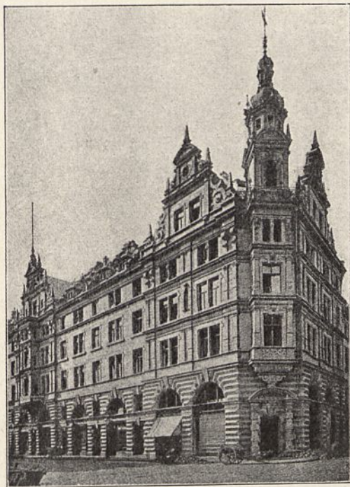
Abb. 576. Häusergruppe in der Hasengasse in Frankfurt a. M.
