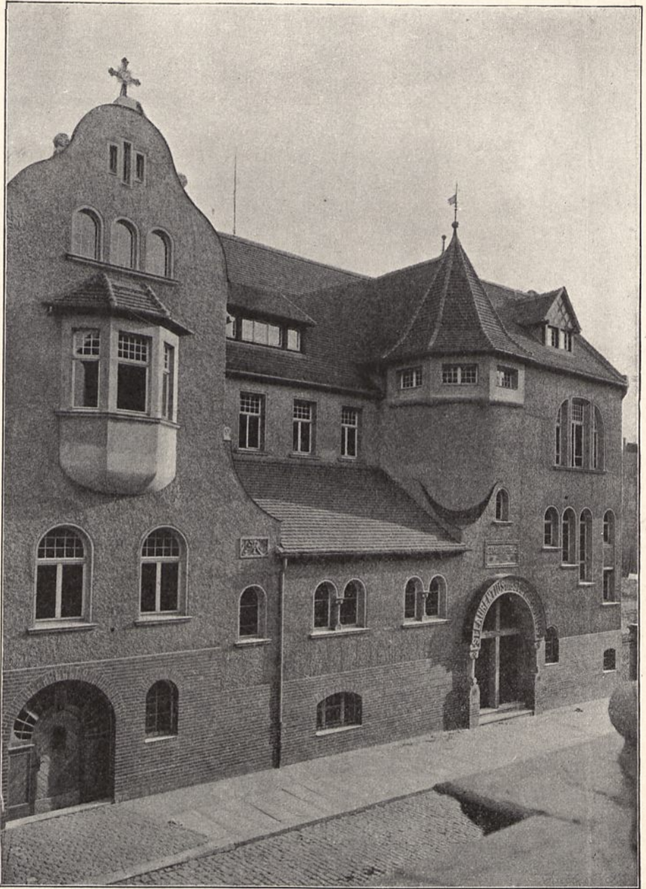
Abb. 587. Gemeindehaus in Halle.
