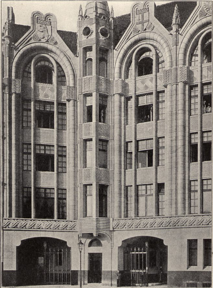
Abb. 466. Verwaltungsgebäude Siemens & Halske in Berlin.
