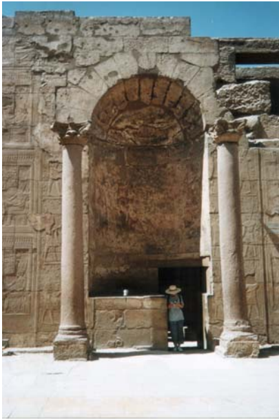
Rys. 169 Świątynia luksorska. Wejście do sanktuarium. Stan obecny
