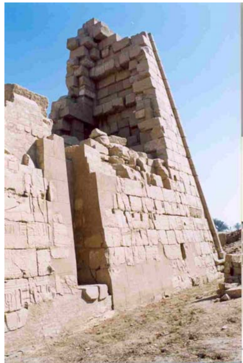
Rys. 154 Okręg Amona. IX pylon. Stan obecny
