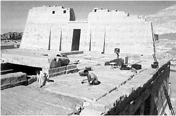
Rys. 205 Medinet Habu. Świątynia Amona. Prace restauracyjne na dachu świątyni. Stan obecny
