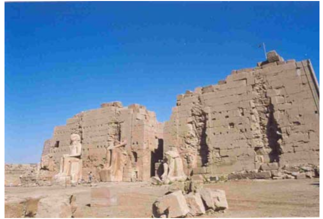
Rys. 148 Okręg Amona. VIII pylon. Stan obecny
