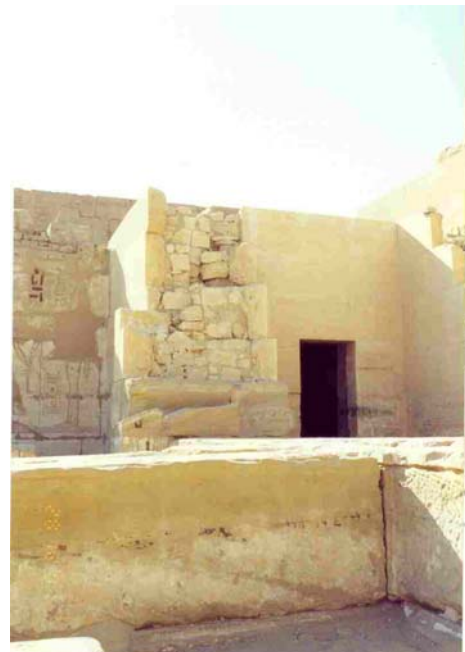
Rys. 208 Medinet Habu. Świątynia Ramzesa III. Prace restauracyjne. Stan obecny
