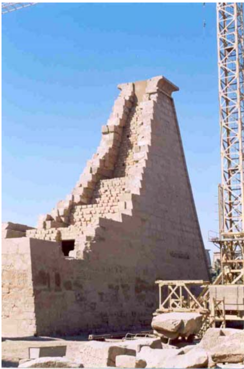
Rys. 153 Okręg Amona. IX pylon. Stan obecny
