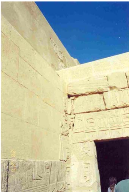
Rys. 207 Medinet Habu. Świątynia Ramzesa III. Prace restauracyjne. Stan obecny
