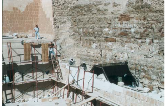
Rys. 102 Świątynia Hatszepsut. Górny taras. Kompleks słoneczny. Prace restauracyjne, rok 2002
