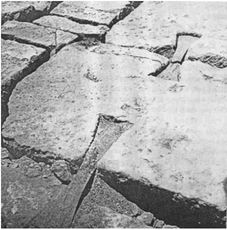
Rys. 151 Okręg Amona. IX pylon. Jaskółcze ogony
