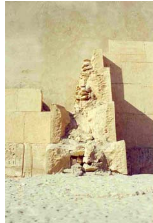
Rys. 206 Medinet Habu. Świątynia Ramzesa III. Prace restauracyjne. Stan obecny
