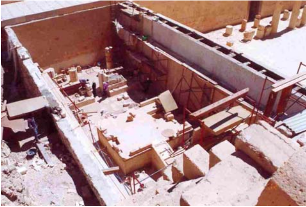
Rys. 101 Świątynia Hatszepsut. Górny taras. Kompleks słoneczny. Prace restauracyjne, rok 2002
