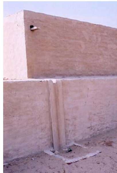
Rys. 268 Świątynia Merenptaha. Drugi pylon z komorą na przechowywanie bloków. Odprowadzenie wody. Stan obecny
