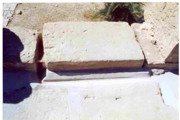
Rys. 202 Medinet Habu. Świątynia Amona. Prace restauracyjne na dachu świątyni. Stan obecny
