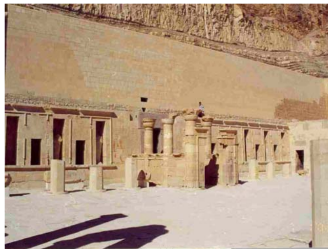
Rys. 75 Świątynia Hatszepsut. Ściana zachodnia dziedzińca wraz z ścianą osłonową. Stan obecny
