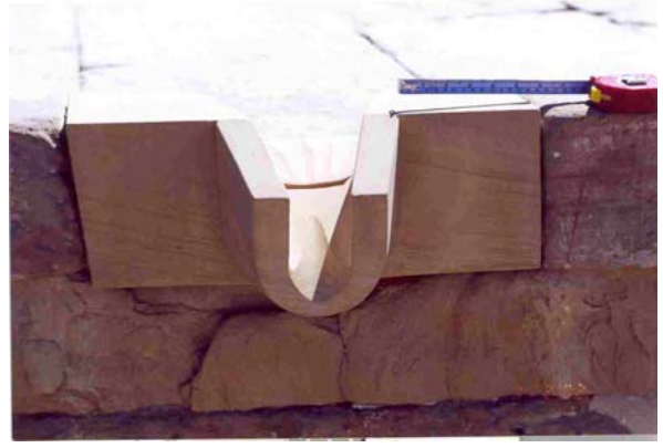
Rys. 204 Medinet Habu. Świątynia Amona. Prace restauracyjne na dachu świątyni. Rekonstrukcja elementu odprowadzającego wodę z dachu. Stan obecny
